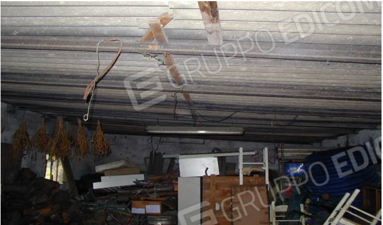
FOTO N. 3 – INTERNO FABBRICATO DA DEMOLIRE
