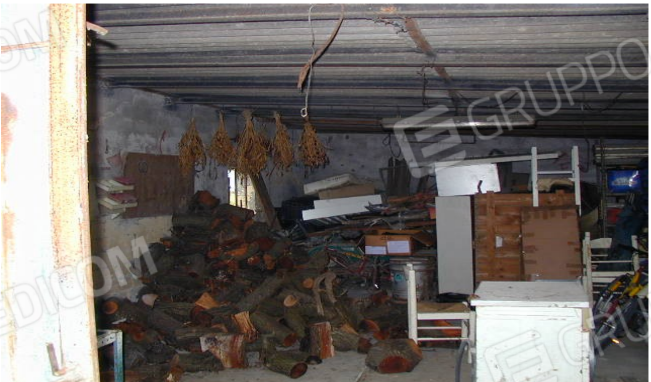
FOTO N. 2 – INTERNO FABBRICATO DA DEMOLIRE
