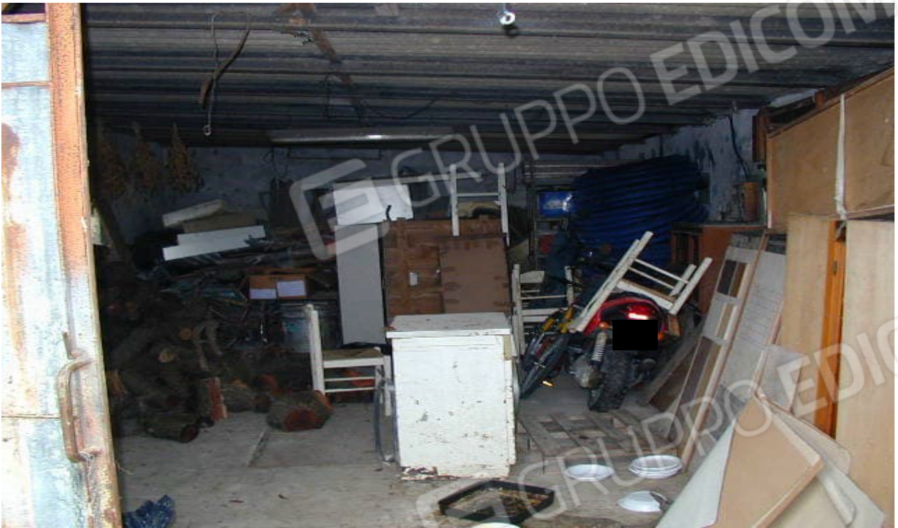
FOTO N. 1 – INTERNO FABBRICATO DA DEMOLIRE
