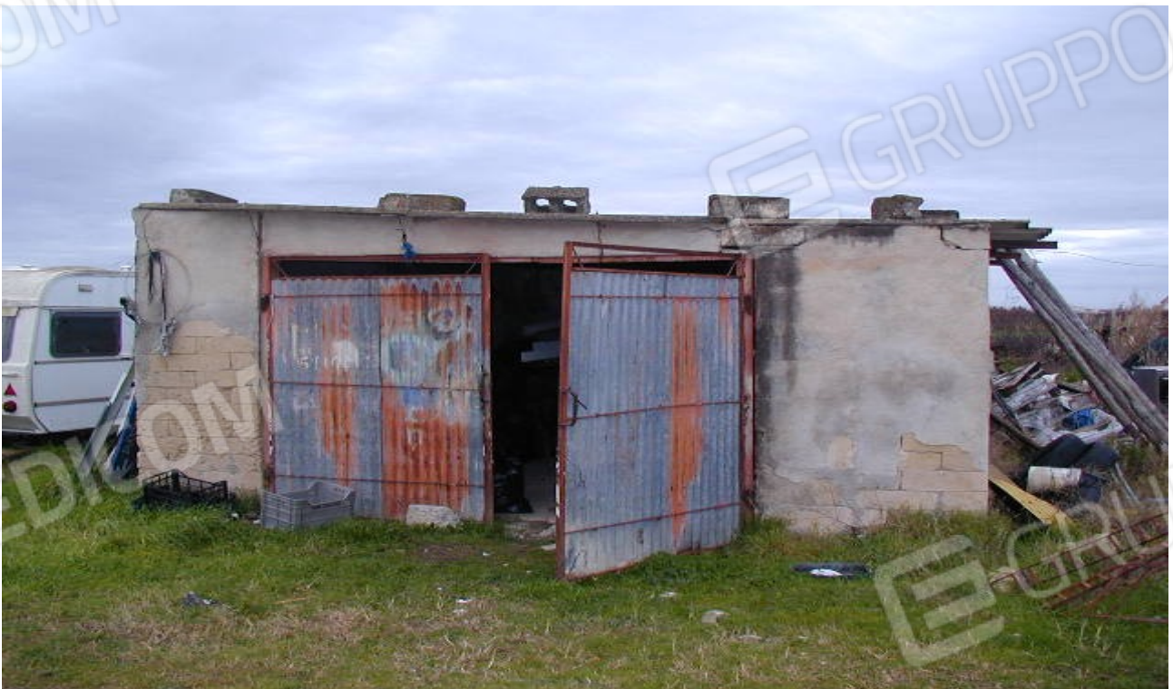
FOTO N. 6 – ESTERNO FABBRICATO DA DEMOLIRE
