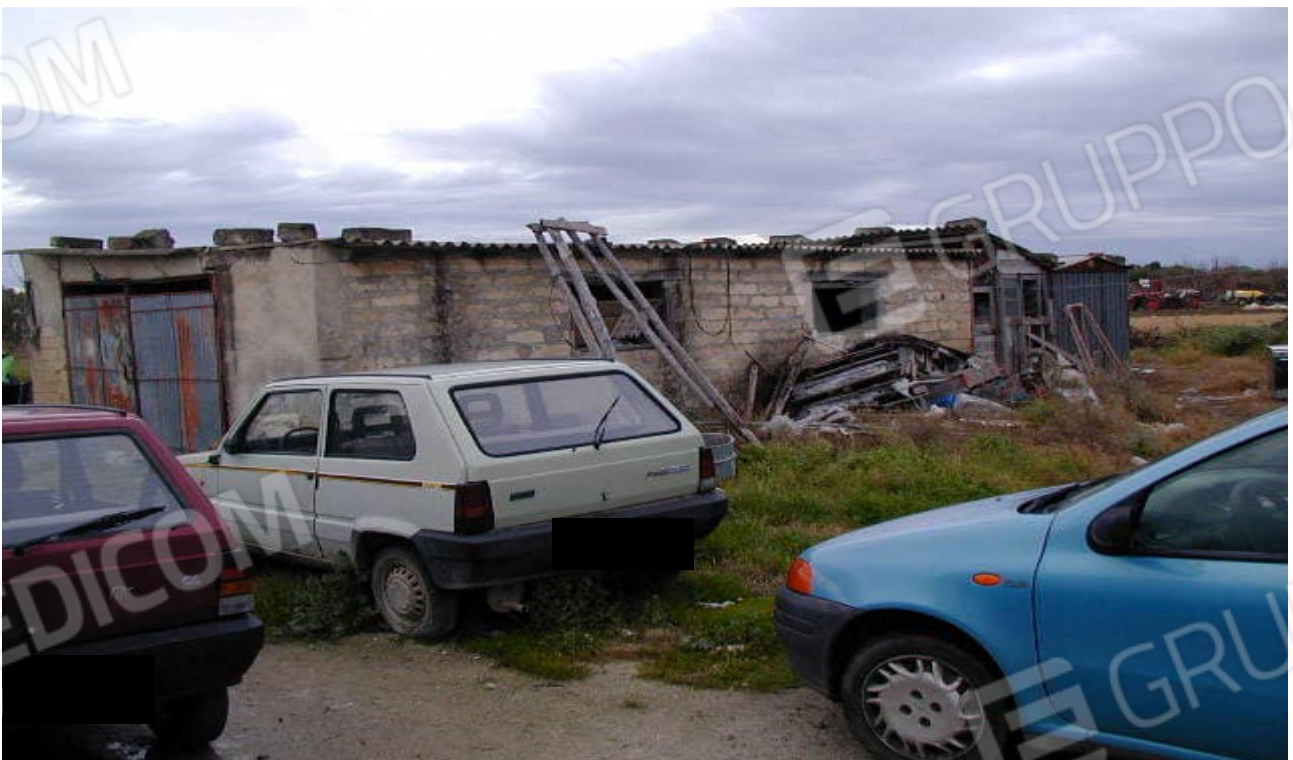
FOTO N. 24 – FABBRICATO ESTERNO DA DEMOLIRE
