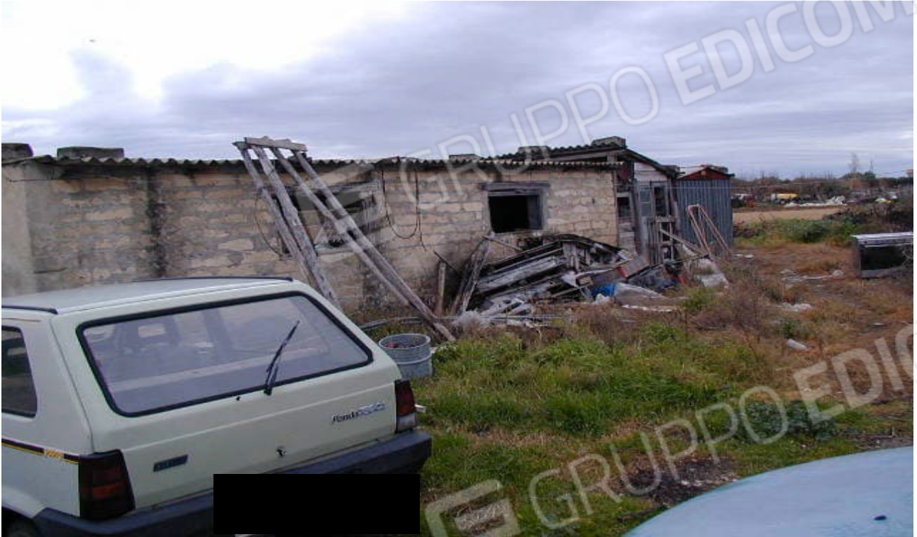
FOTO N. 7 – ESTERNO FABBRICATO DA DEMOLIRE
