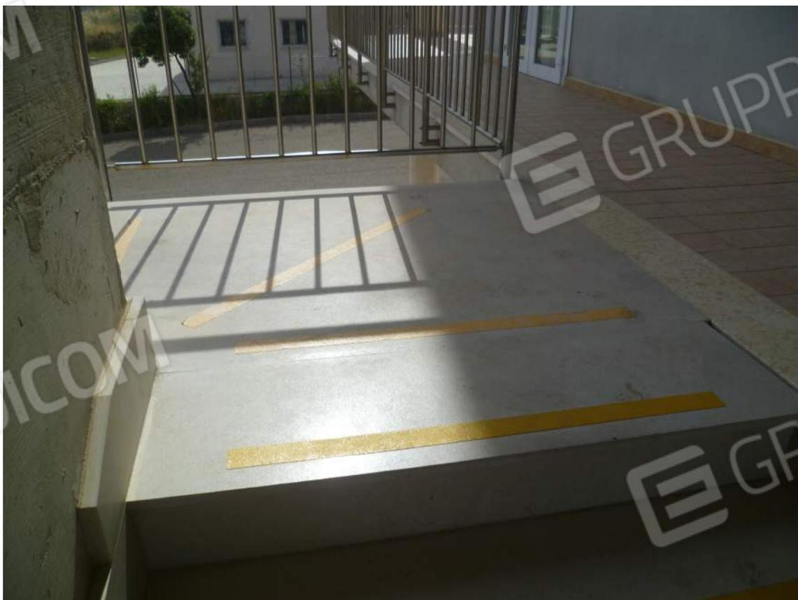
La scala in cemento faccia vista col rivestimento in marmo. I ballatoi sono pavimentati col gres. I parapetti sono in acciaio
