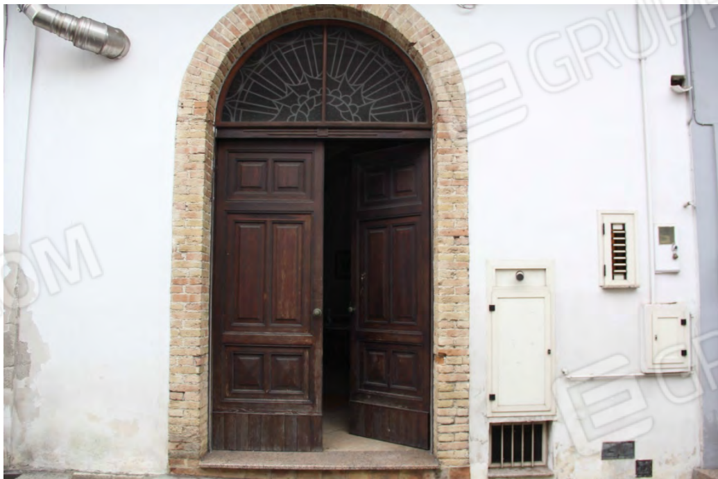
Foto 10- 11-12- prospetto su via Di Giulio
