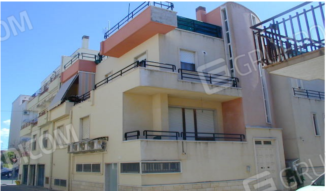
Foto n. 8 – Prospetto esterno fabbricato in via Bradano
