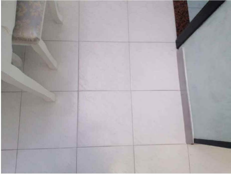
Foto n. 7 – particolare pavimento interno
