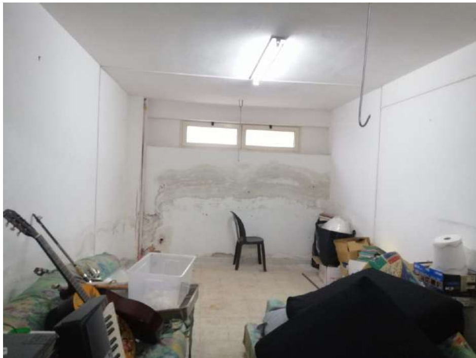
Foto n. 10 – interno ripostiglio al piano seminterrato
