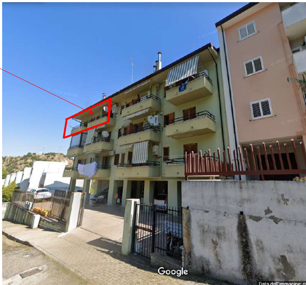
Foto n. 1 – prospetto principale viale della Pineta
