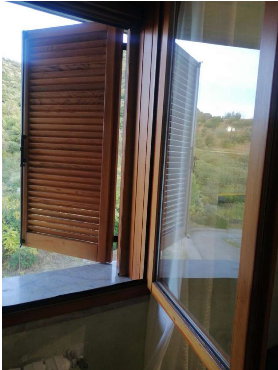
Foto n. 5 – particolare infisso esterno in legno
