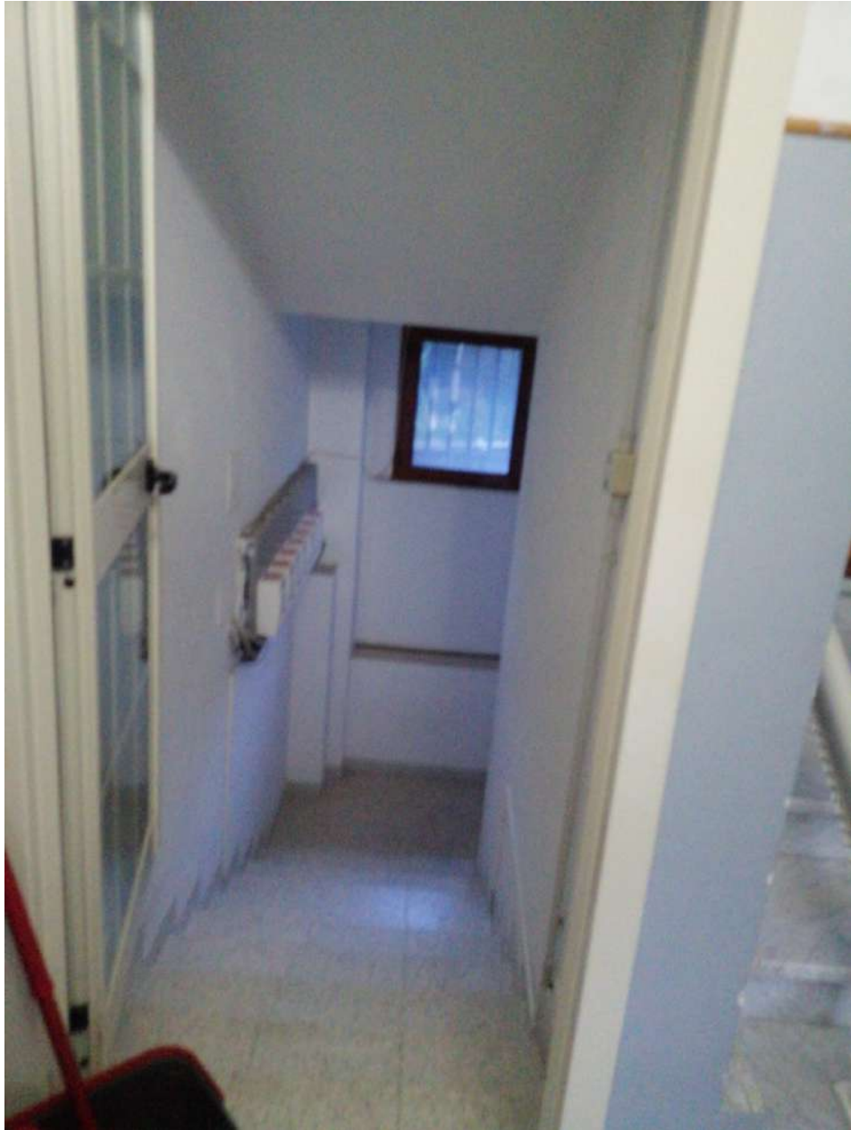
Foto n. 6 – vano scala condominiale per accesso ripostiglio
