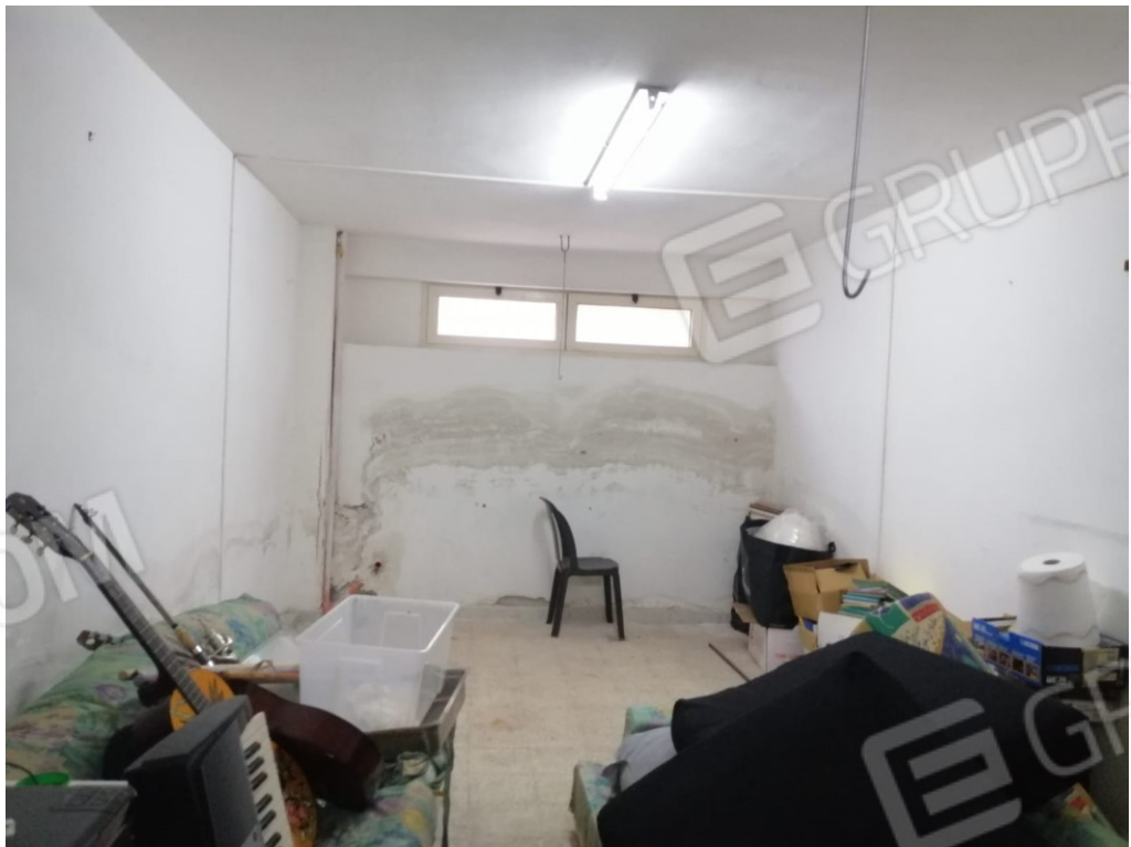
Foto n. 10 – interno ripostiglio al piano seminterrato
