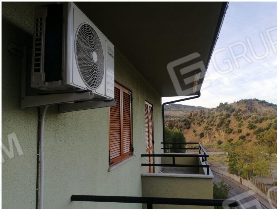
Foto n. 4 – particolare balcone su prospetto posteriore
