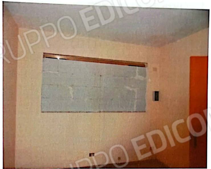
Foto n. 10: Deposito (finestra murata)
