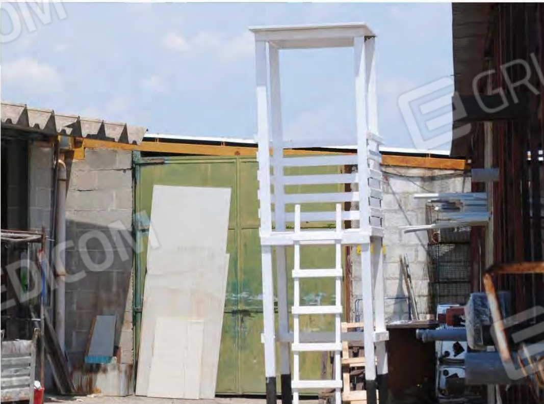
Corpo D: Vista esterna – Portone di ingresso dal piazzale
