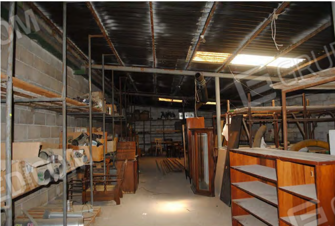
Corpo D: Vista interna
