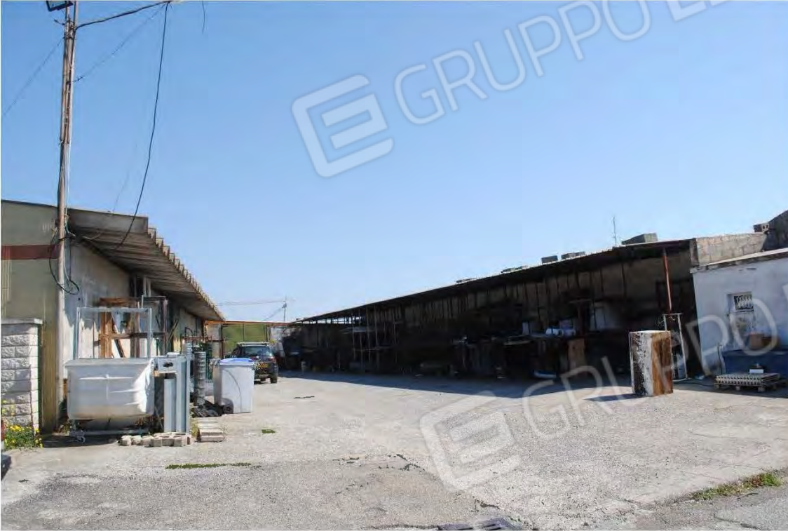
Corpo D: Vista esterna - Vista interna al piazzale-Corpi A,C,D,E
