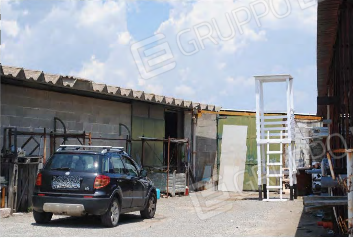
Corpo C: Vista esterna – Prospetto laterale dx–ingresso dal piazzale
