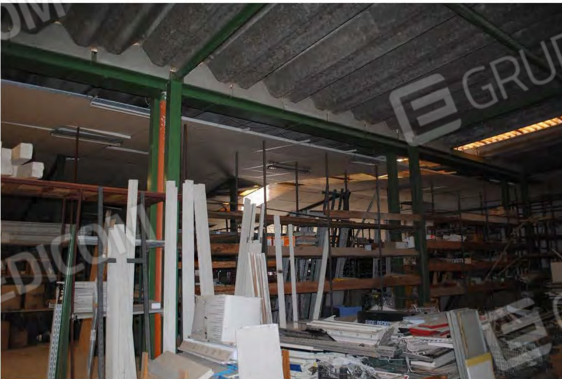
Corpo C: Vista Interna
