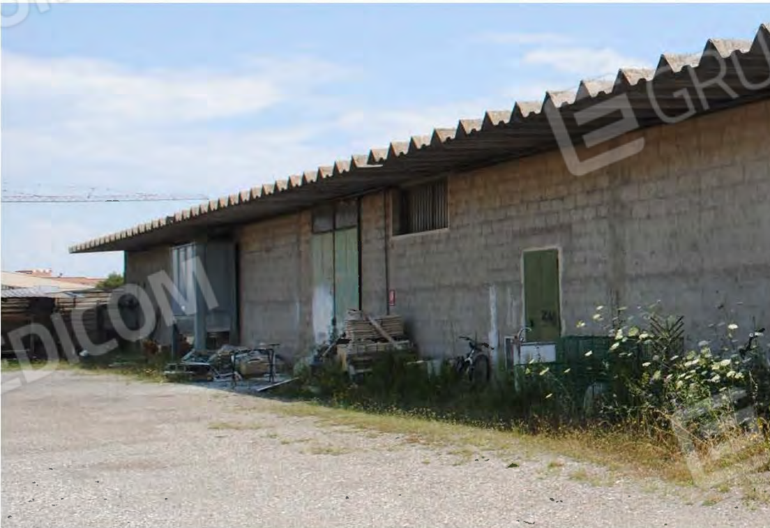
Corpo C: Vista esterna dal piazzale – Prospetto laterale sx
