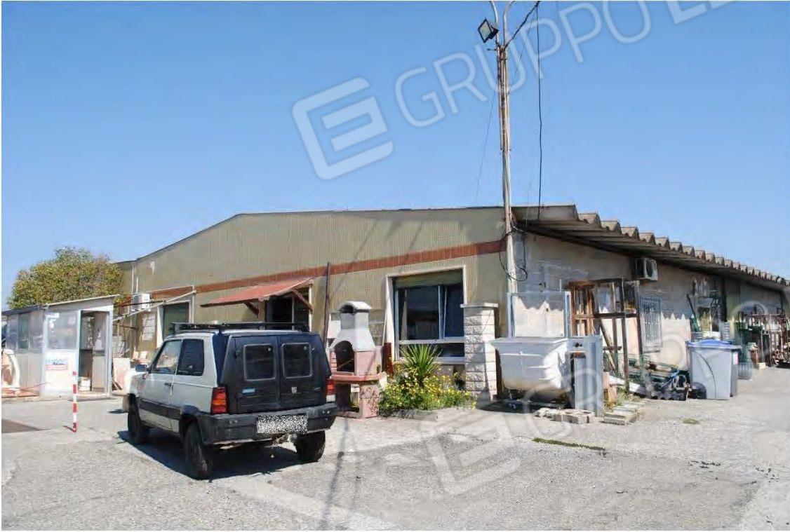
Corpo A: Vista esterna - Vista interna al piazzale-
