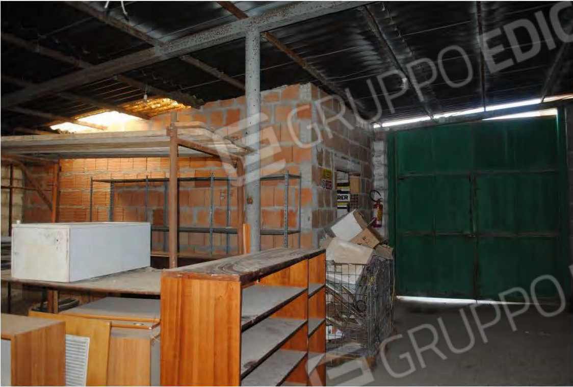
Corpo D: Vista interna
