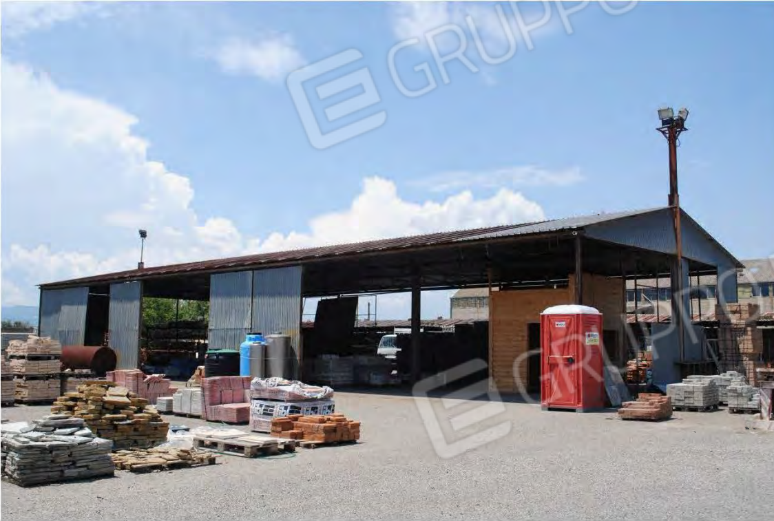
Corpo F: Vista esterna, interna al piazzale
