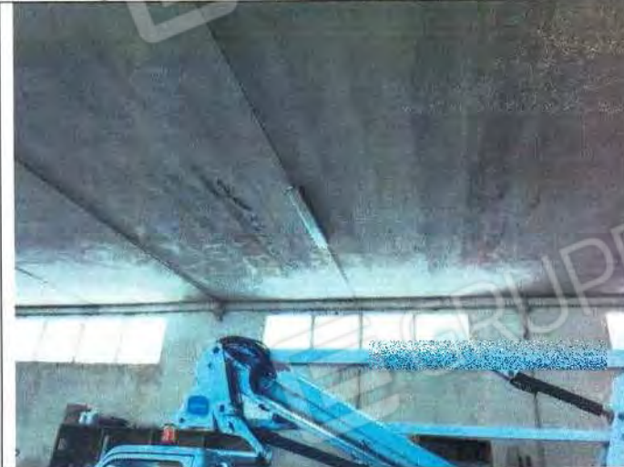
Particolari interno opificio con visione del solaio con infiltrazioni idriche
