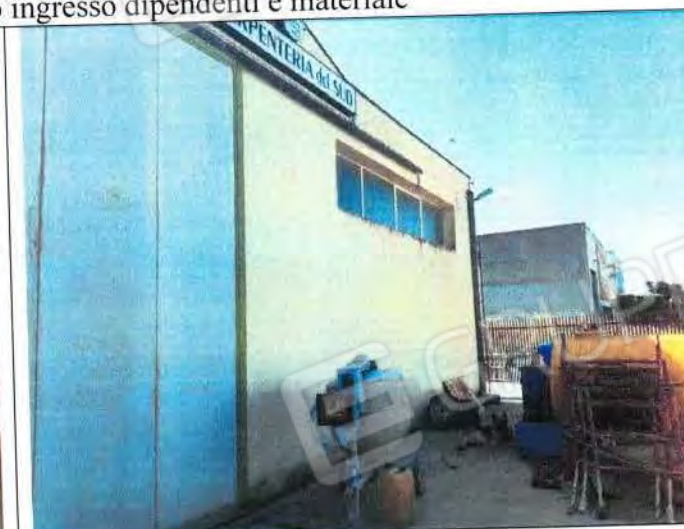
Ingresso e area esterna di stoccaggio materiale
