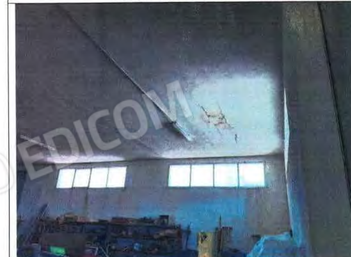
Particolari interno opificio con visione del solaio con infiltrazioni idriche
