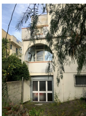
ACCESSO AL SEMINTERRATO
