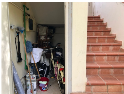
DEPOSITO SOTTOSCALA A QUOTA GIARDINO
