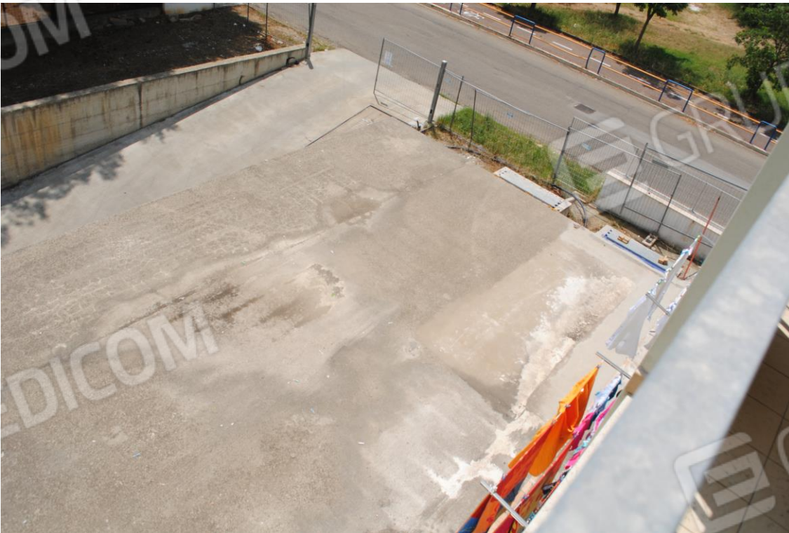
Vista Esterna - Ingresso rampa Box – Via Monreale
