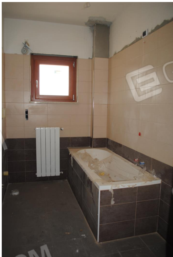
Vista Interna- Alloggio – bagno vasca
