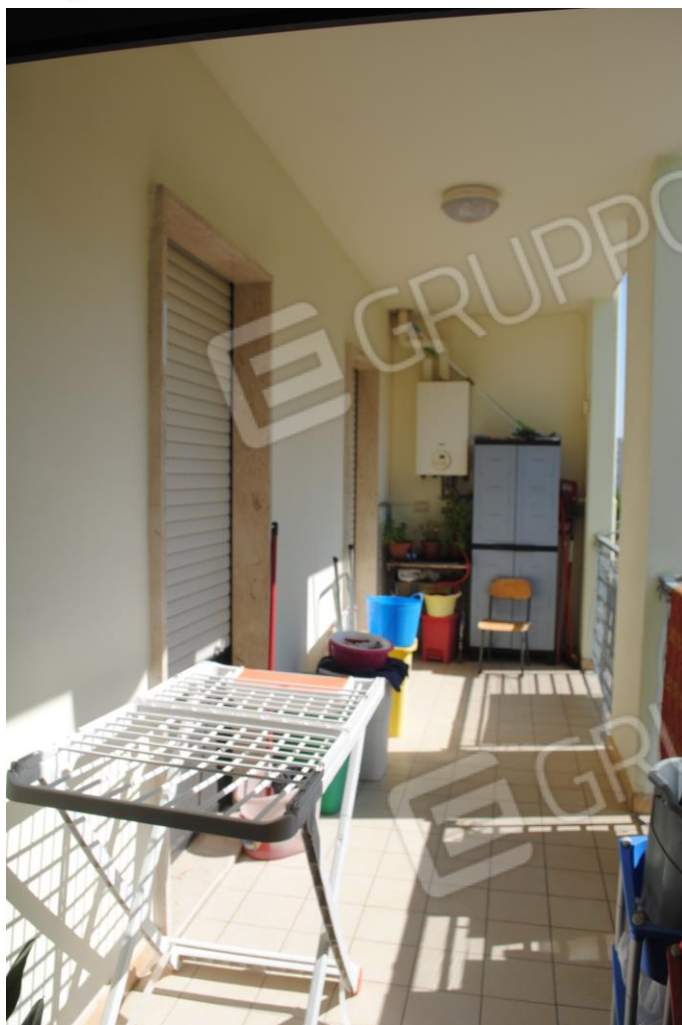
Vista Esterna - Balconi prospetto posteriore
