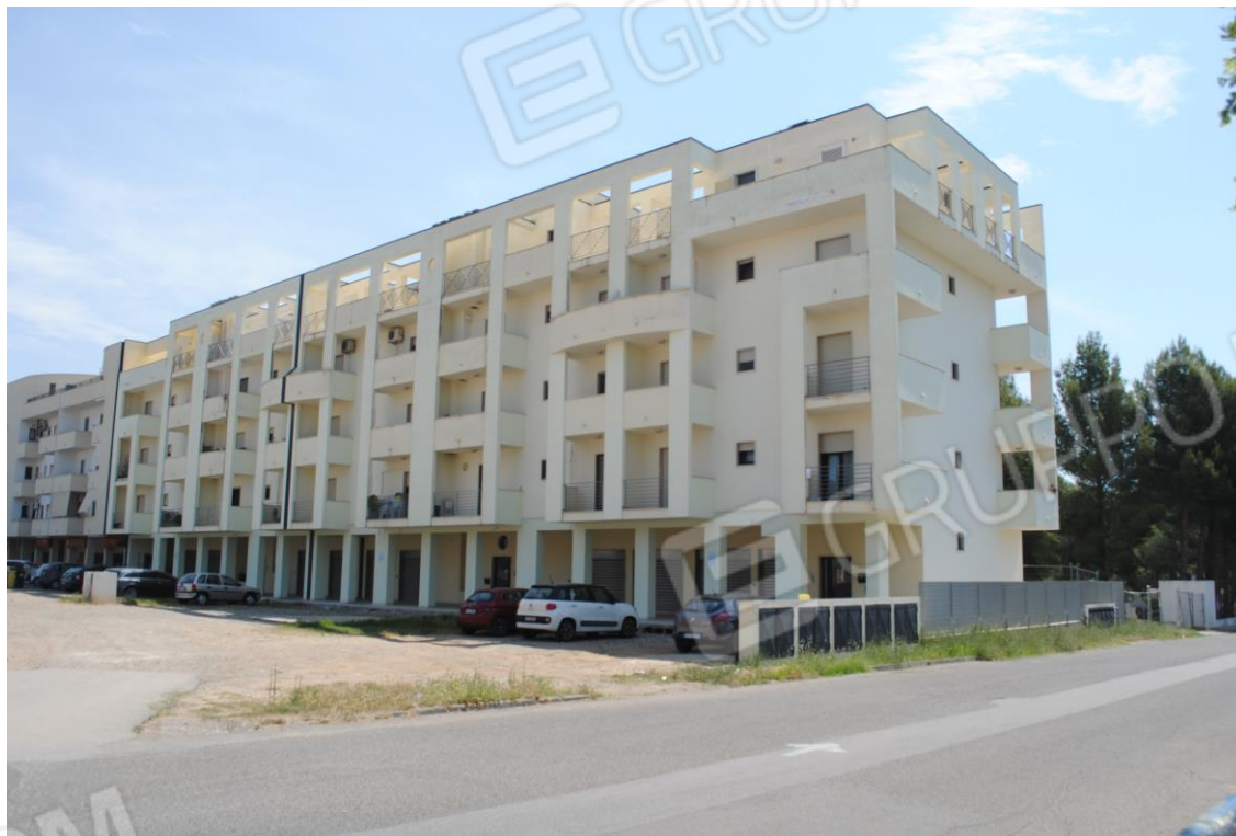
Vista Esterna – Via Togliatti angolo Via Monreale
