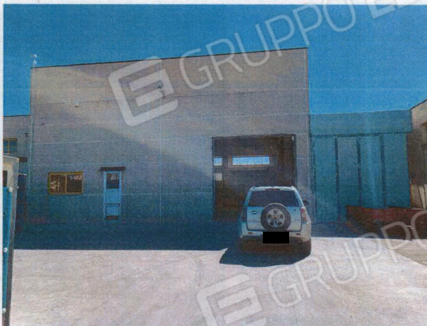
Foto n. 1: Prospetto principale capannone
