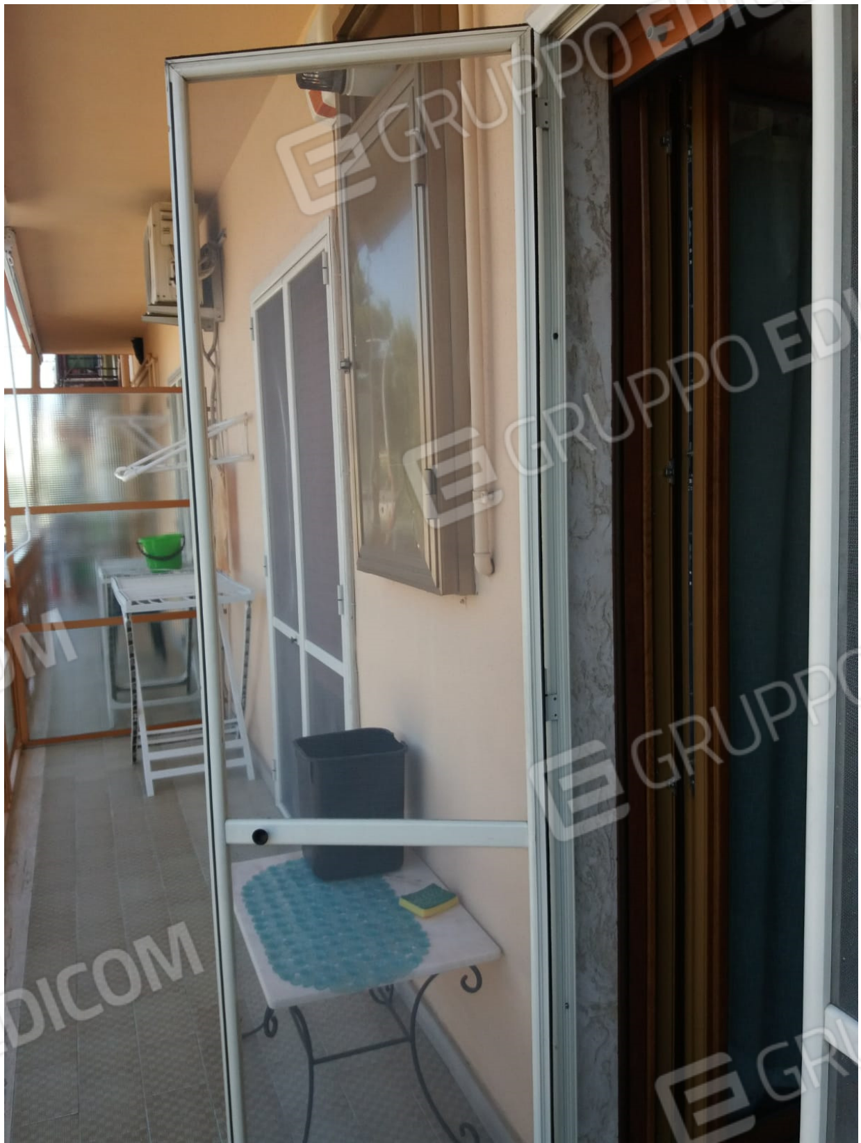
FOTO N. 9 BALCONE SU VIA LANZILLOTTI
