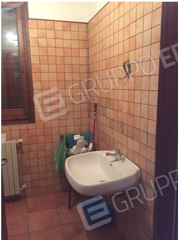
FOTO N.10 INTERNO – Ripresa vista vano bagno abitazione piano T.
