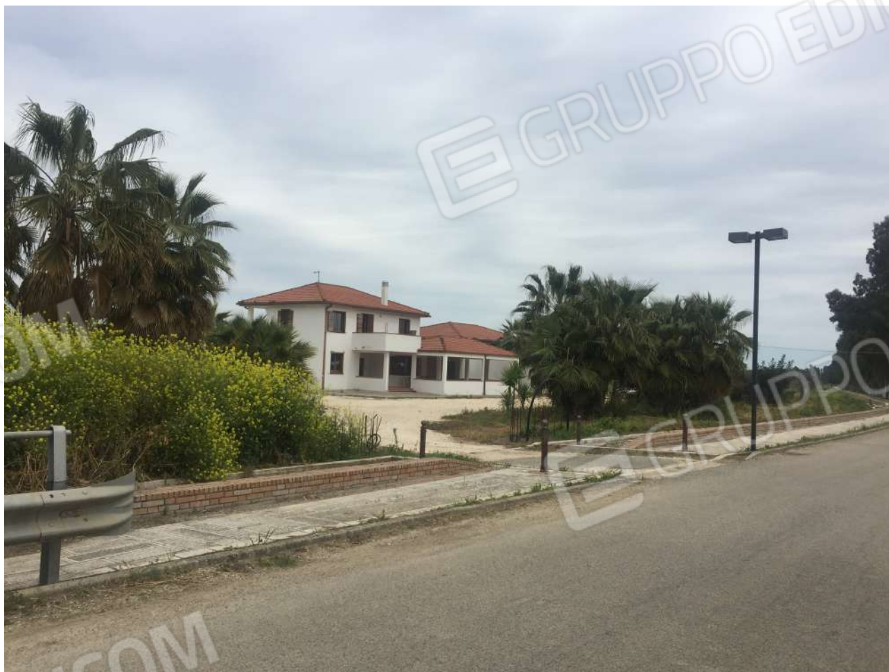
FOTO N.1 ESTERNO – Ripresa fabbricato Strada comunale per Sansone
