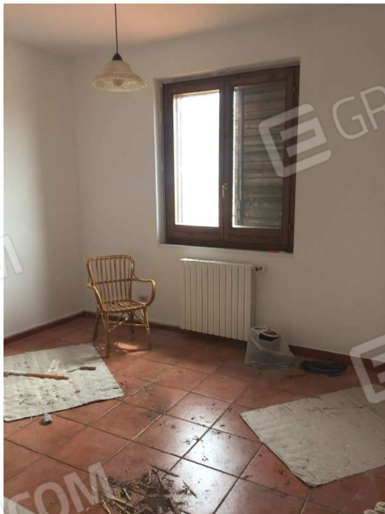
FOTO N.13 INTERNO – Ripresa vista vano soggiorno abitazione piano 1°
