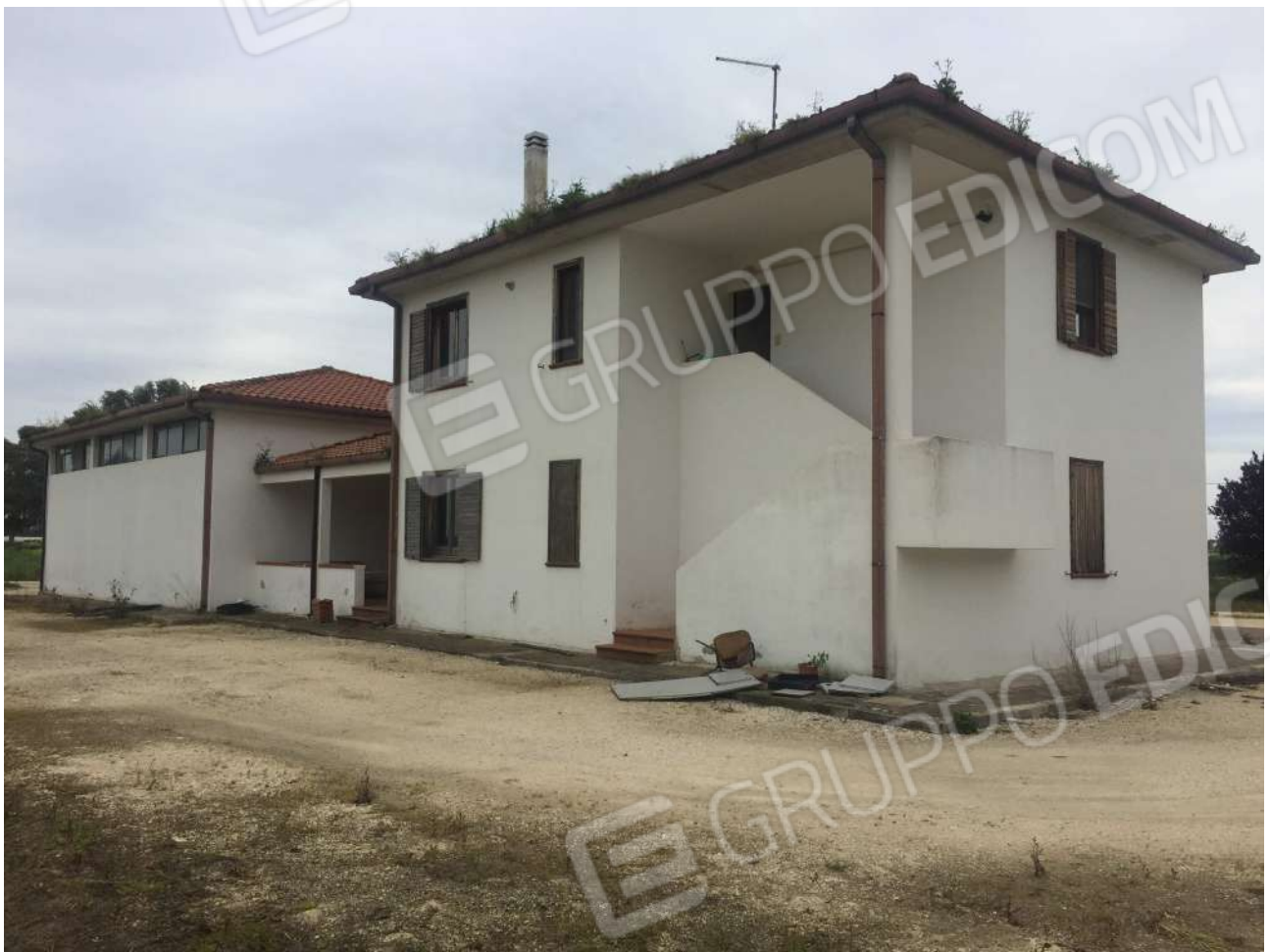
FOTO N.6 ESTERNO – Ripresa fabbricato vista retrostante ingresso piano 1°
