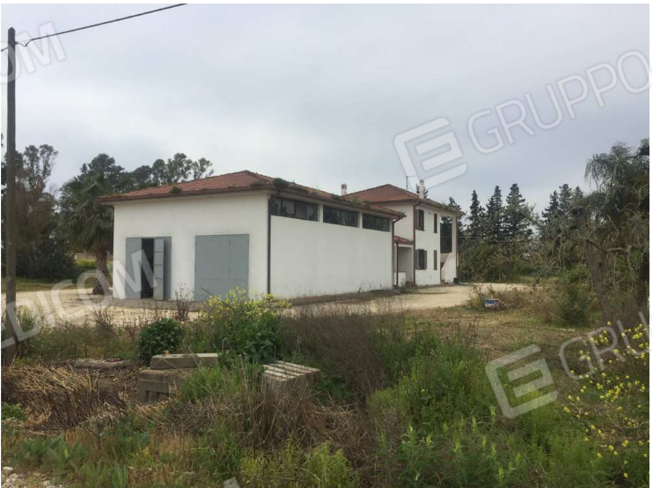
FOTO N.5 ESTERNO – Ripresa fabbricato capannone deposito
