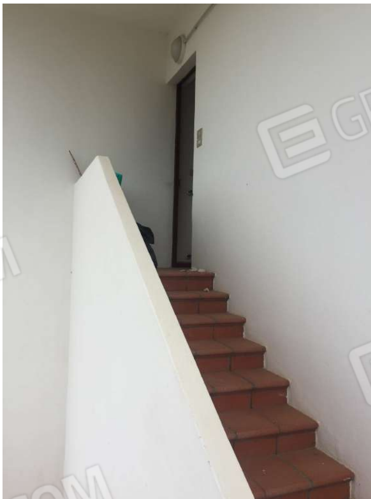
FOTO N.11 ESTERNO – Ripresa fabbricato vista scalinata ingresso piano 1°
