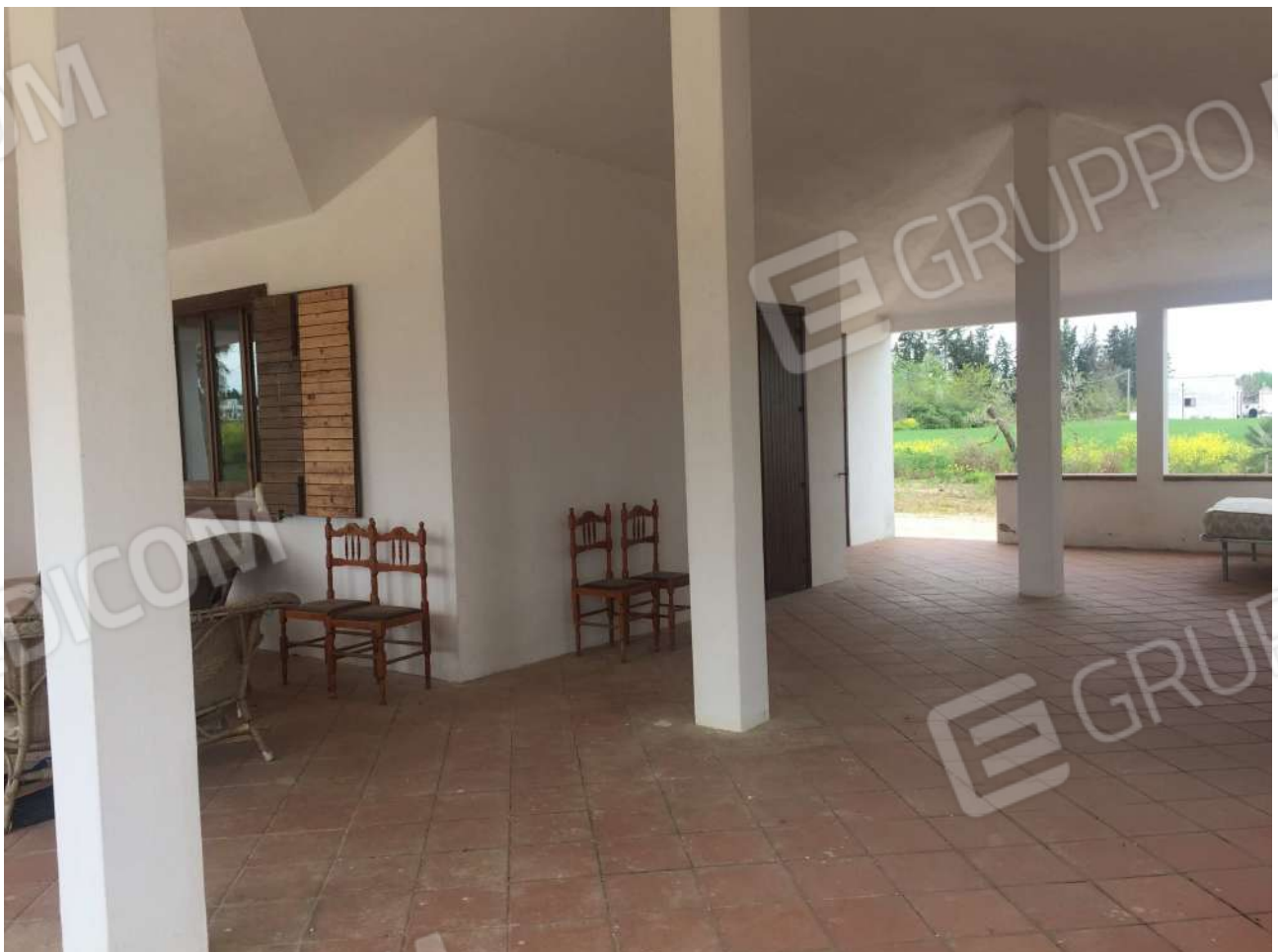
FOTO N.7 ESTERNO – Ripresa fabbricato vista porticato piano T.
