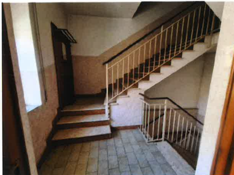
Vano scala piano primo
