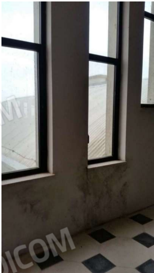
Foto 13: Infiltrazione e degrado nel locale seminterrato
