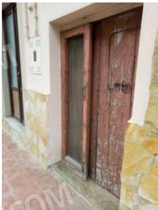
Figura 7. Particolare portoncino piano primo sottostrada.
