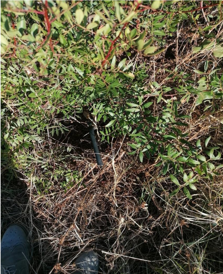
Foto 15 (particolare impianto irriguo invaso da essenze spontanee – lentisco- fillirea etc)
