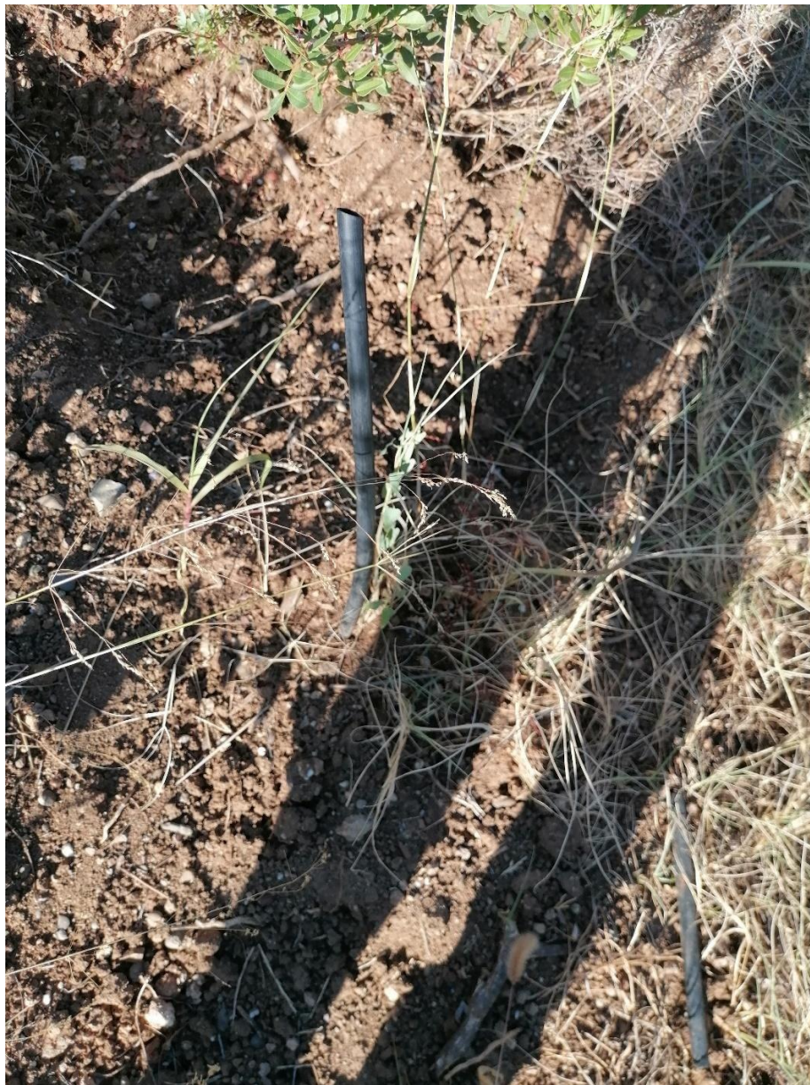
Foto 14 (particolare residui di impianto irriguo)
