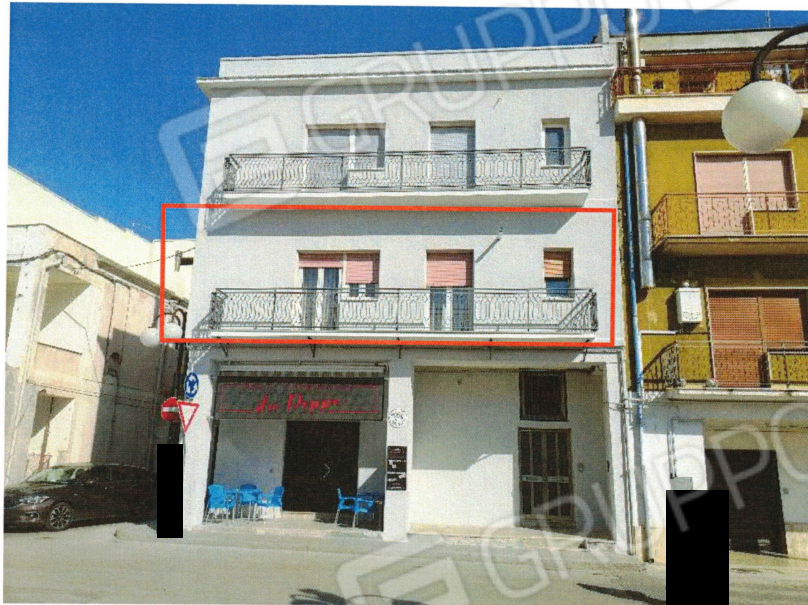
Foto n. 1 – prospetto prospiciente via Torino
