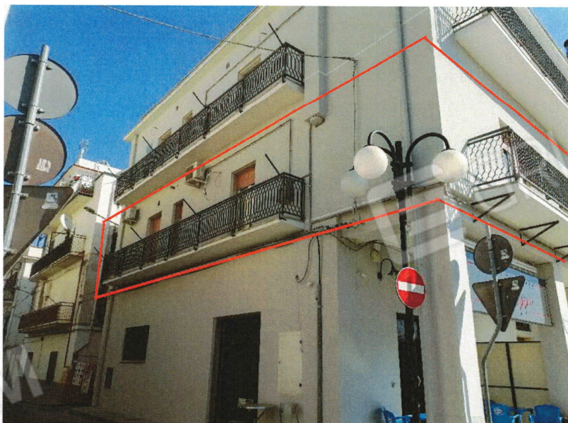
Foto n. 2 – prospetto via Salasco
