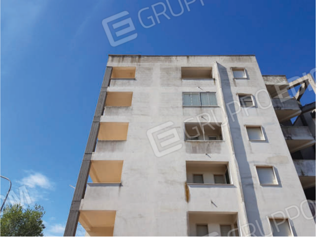
Fg 43 particella 503 sub 33 Prospetto esterno
