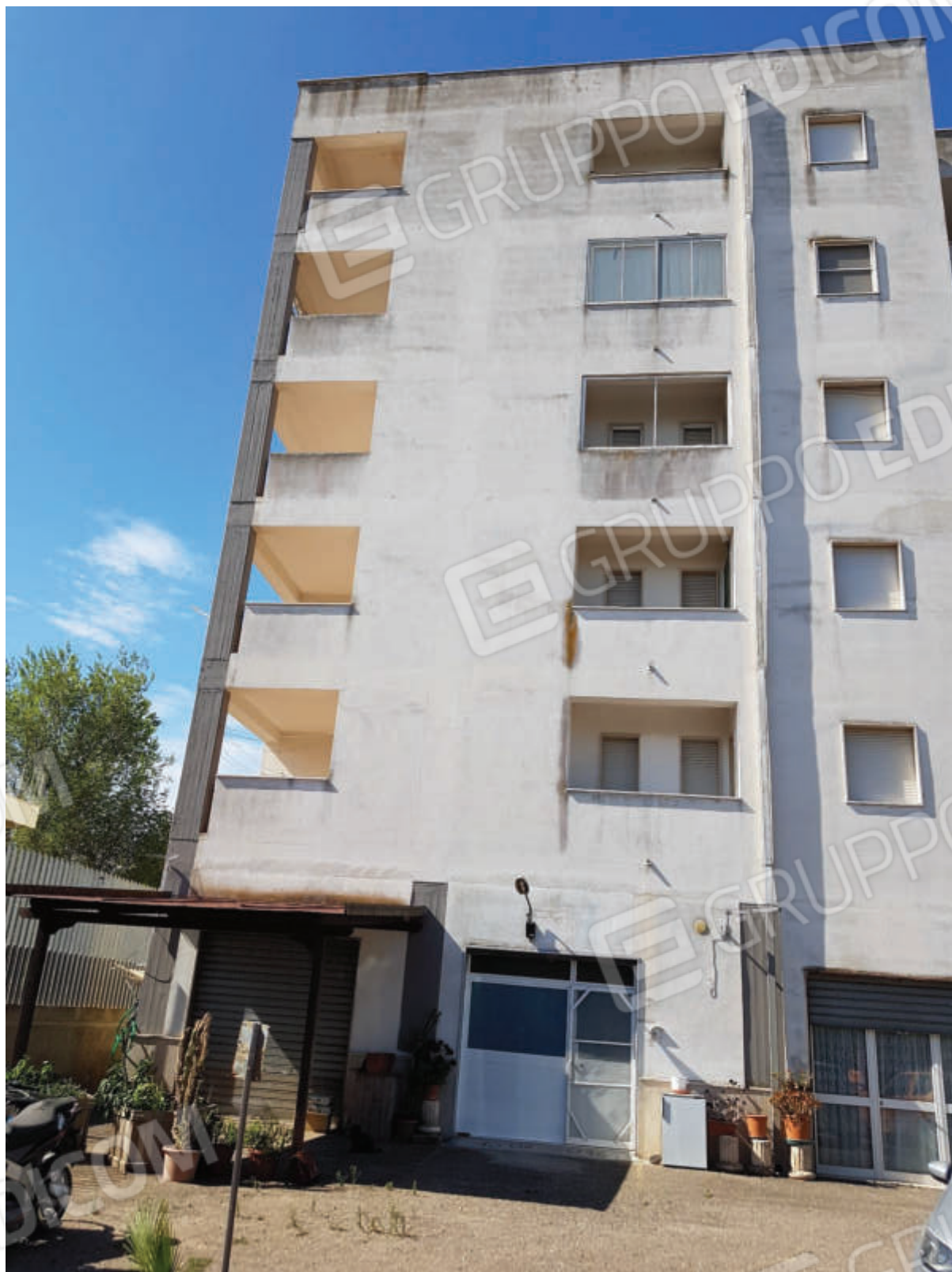
Fg 43 particella 503 sub 33 - 34 Prospetto esterno
