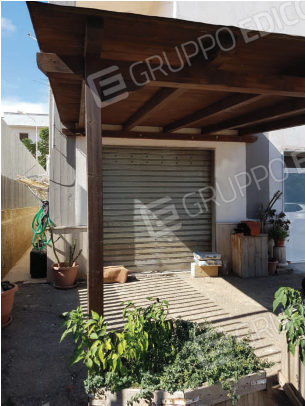
Autorimessa Fg 43 particella 503 sub 34
