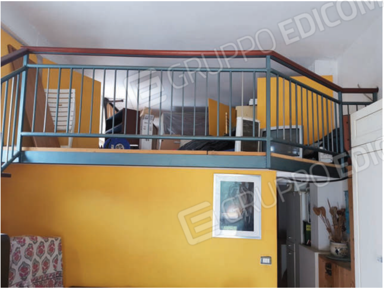
Fg 43 particella 503 sub 34 Autorimessa – soppalco interno
