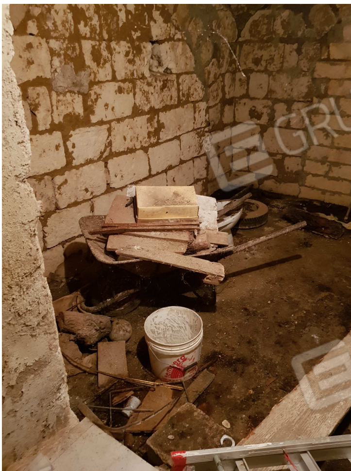
Vista del locale cantina 2
