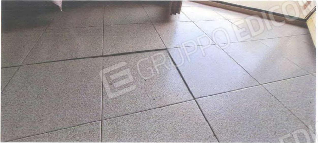
Figura 21 - Sconnessioni nella pavimentazione
