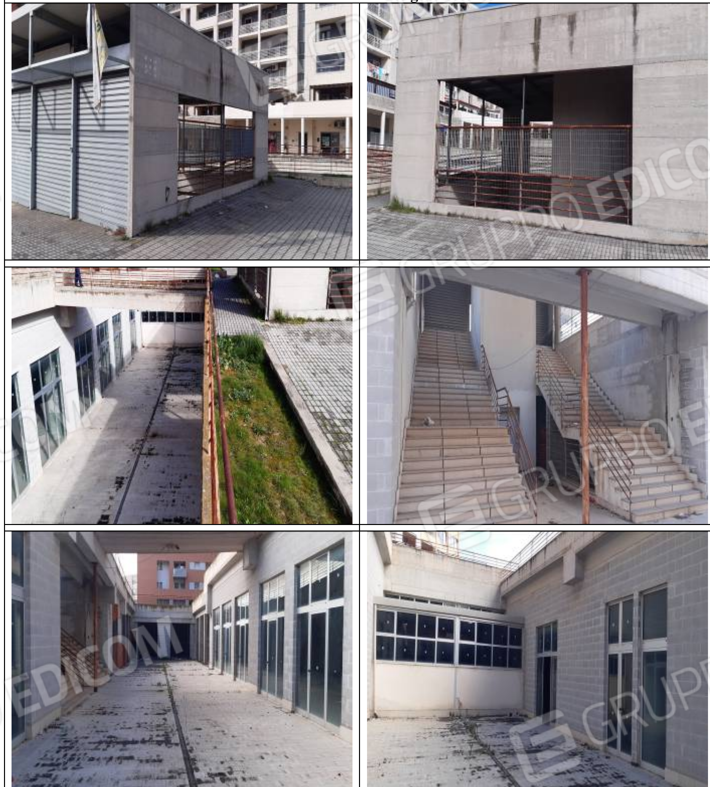
Lotto 001 - Vista esterna dell'unità - Accessi e pertinenze comuni
