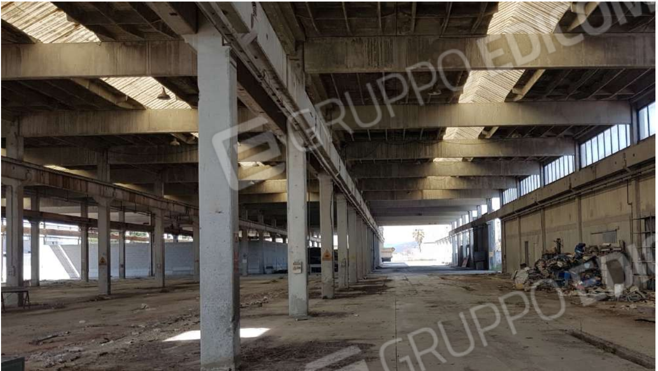
FOTO 1 vista interna del capannone (fg. 15-p.Ila 204-sub.3)
