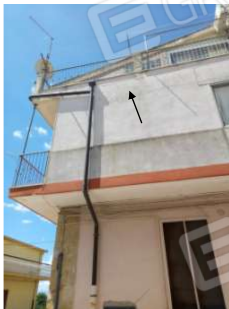
Figura 4. Particolare fessurazione tra il primo e il secondo piano.
