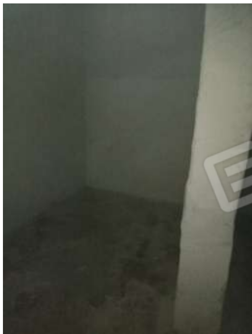
Figura 29. Interni fg78 plla68 sub7
