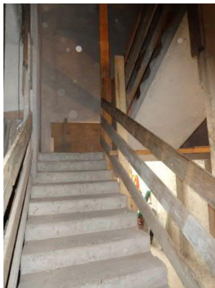
vano scala interno al grezzo
