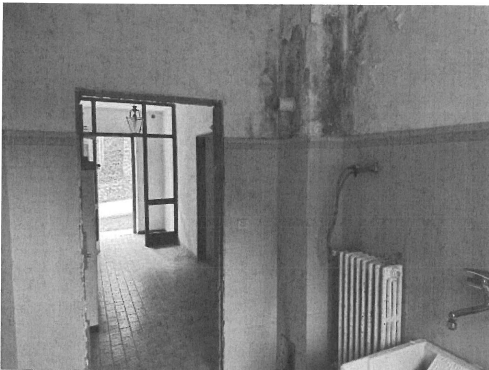
Foto 21: PT (sub. 3) bagno
