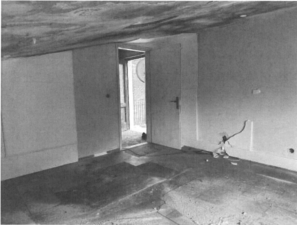
Foto 31: P1 (sub. 3) soffitta angolo Ovest
