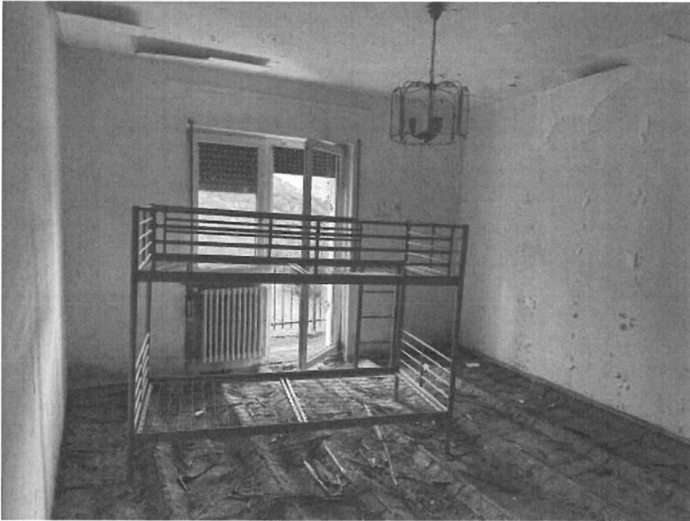
Foto 23: PT (sub. 3) camera angolo Nord
