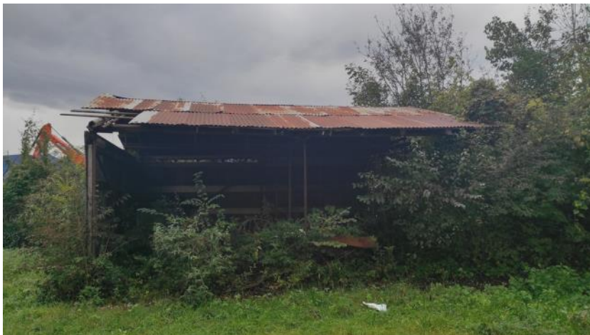
Vista manufatto in legno
