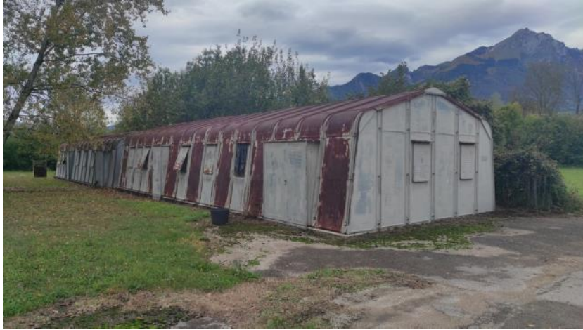
Vista manufatti in metallo
