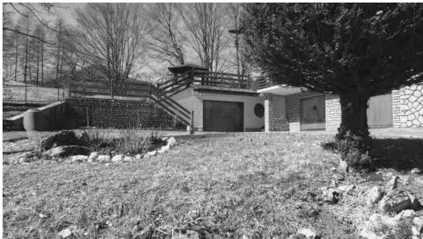
Vista da strada autorimessa e terreno
