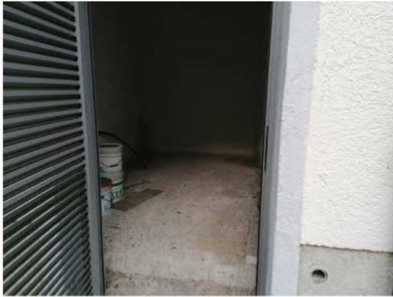
Vano Centrale Termica
