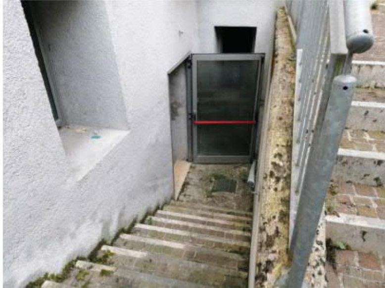
Accesso da Nord
