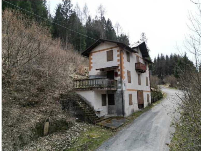
Vista fabbricato da nord
