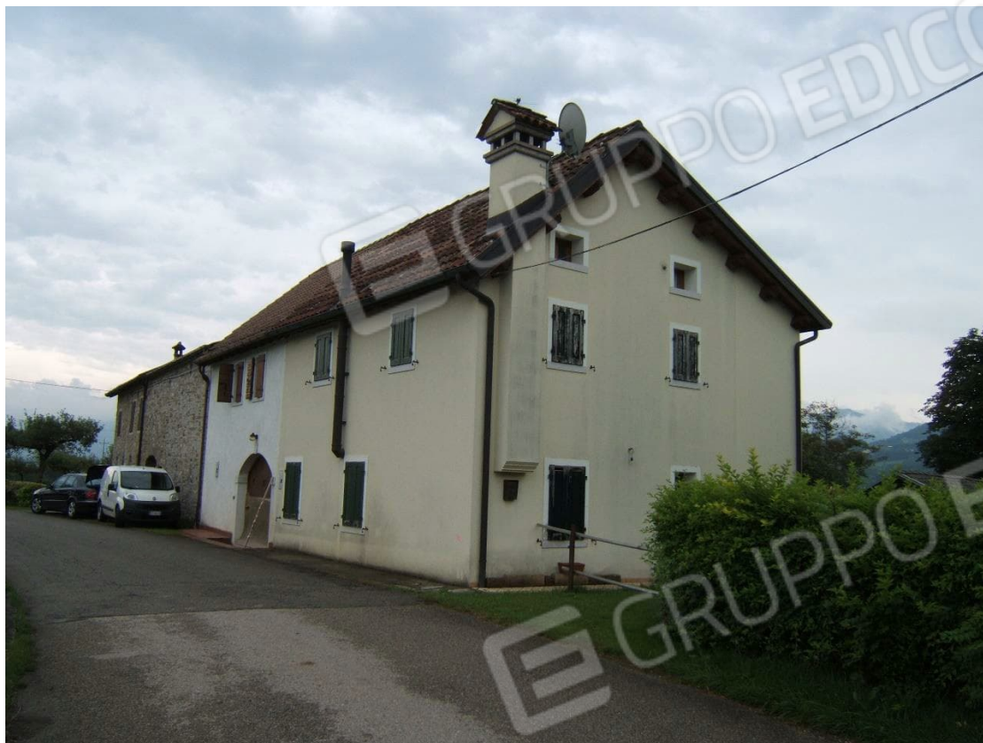
Fronte NORD OVEST da Via Pagogna
