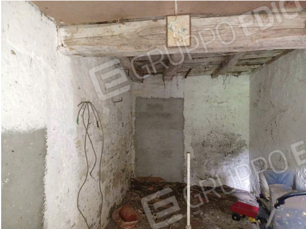
Foto n. 7 : C.F. Fg. 29 mapp. 33 - Piano terra, cantina
