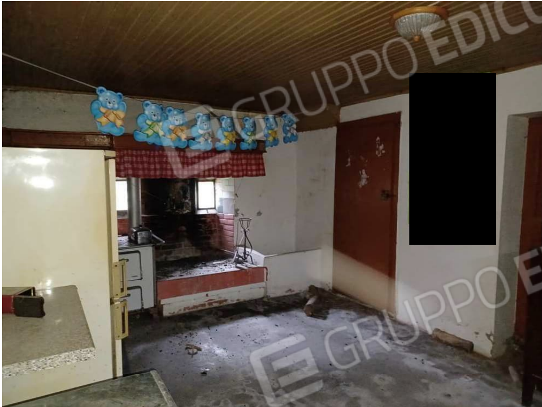
Foto n. 5 : C.F. Fg. 29 mapp. 33 - Piano terra, cucina
