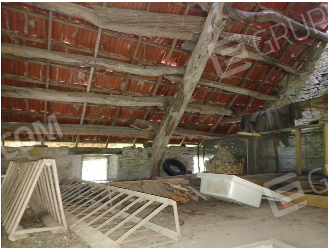
Foto n. 10 : C.F. Fg. 29 mapp. 33 - Piano secondo sottotetto, soffitta
