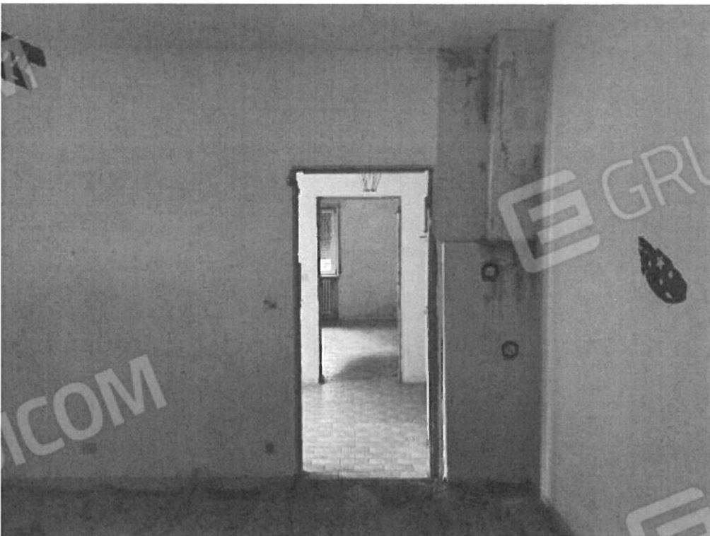
Foto 28: PT (sub. 3) camera angolo Sud
