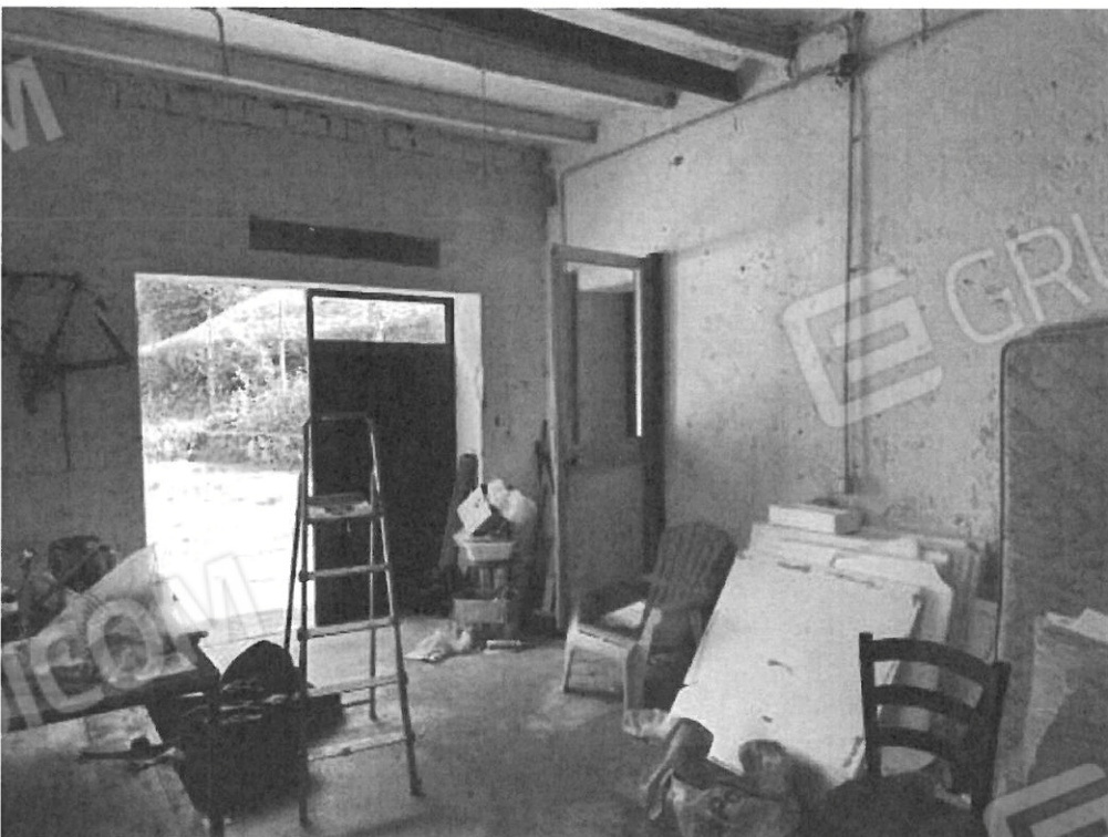
Foto 08: PS1 (sub. 2) autorimessa
