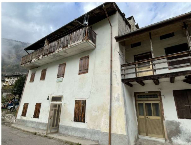
Lato Sud Est del fabbricato
