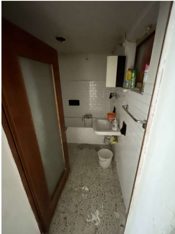
Bagno al PT
