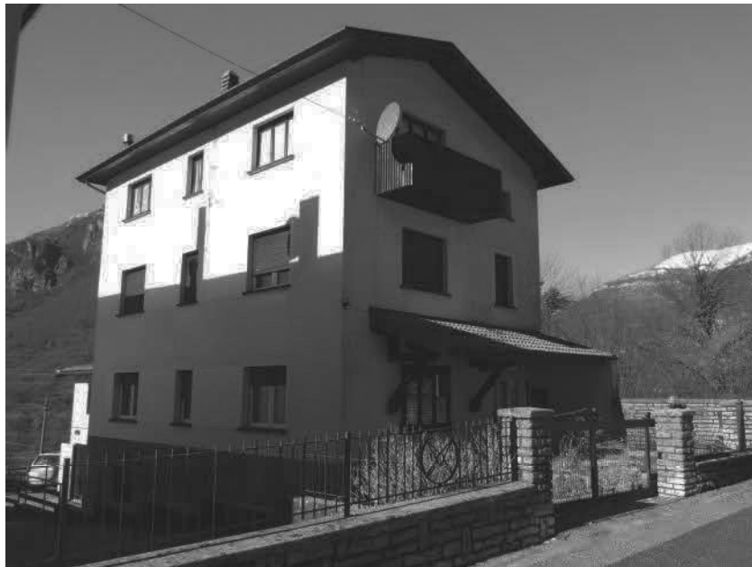
Lato Sud Est del fabbricato particella 590 sub 3
