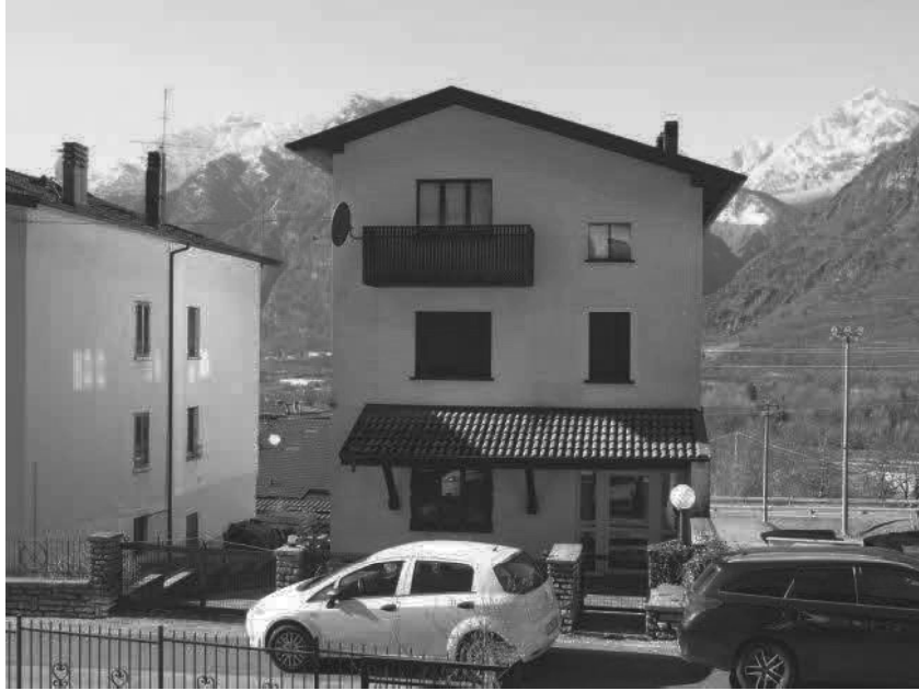
Lato Est – ingresso immobile 590 sub 3
