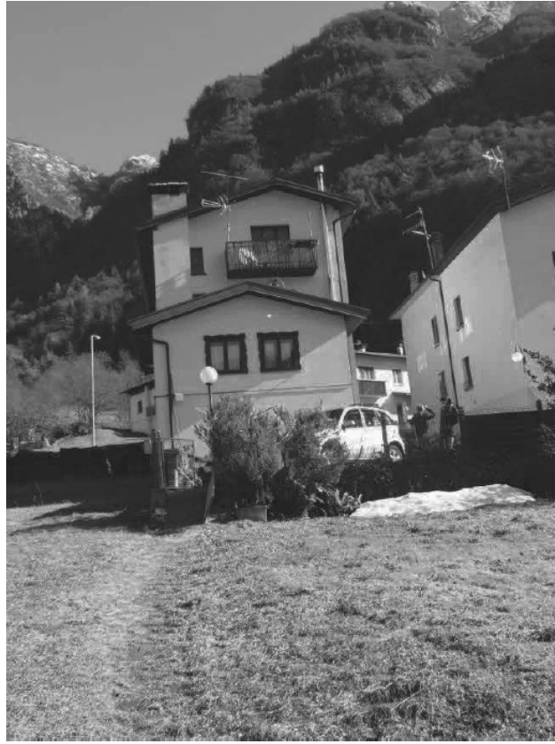
Lato Ovest particella 590
