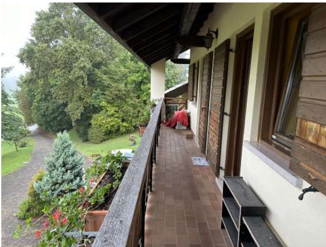
Foto 58: P1 (sub. 3) terrazza fronte Sud-Ovest
