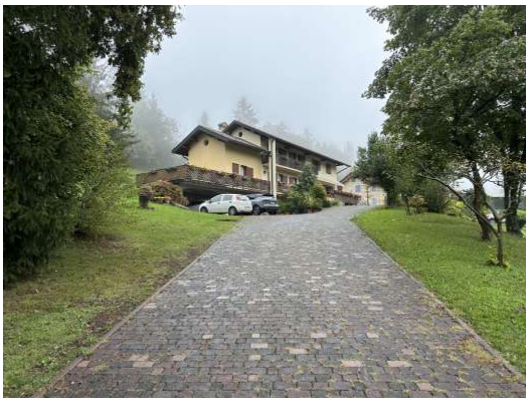
Foto 01: viale accesso con vista all'angolo Ovest del fabbricato
