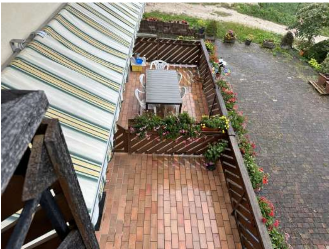
Foto 43: PT (subb. 1 e 3) terrazza sul fronte Sud-Ovest
