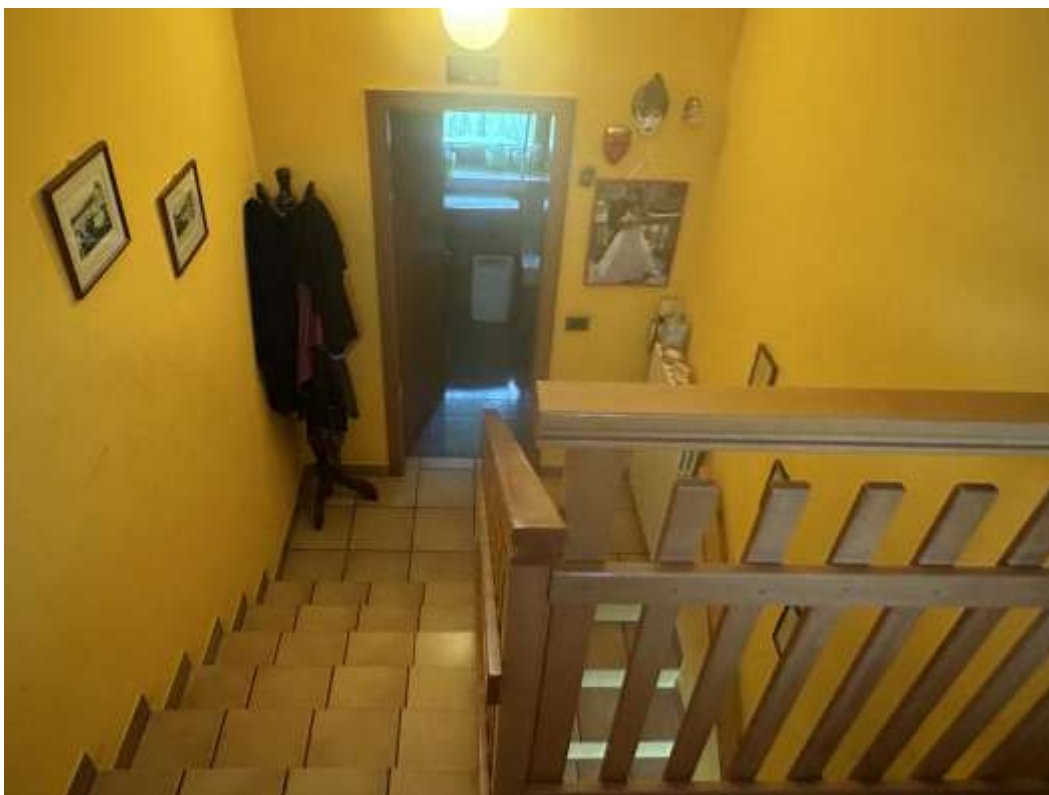
Foto 44: P1 (sub. 3) vano scale interno di collegamento al PT
