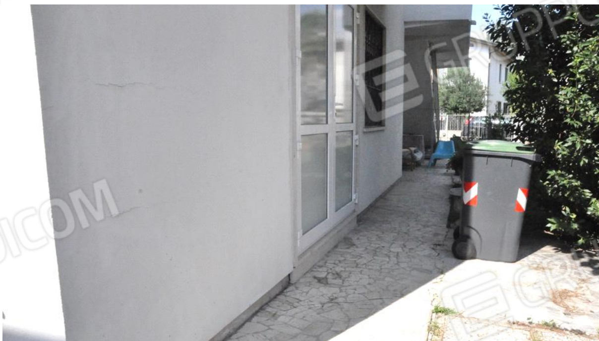
8. Particolare dell'originario ingresso all'autorimessa. All'esterno è rimasto il portone.
