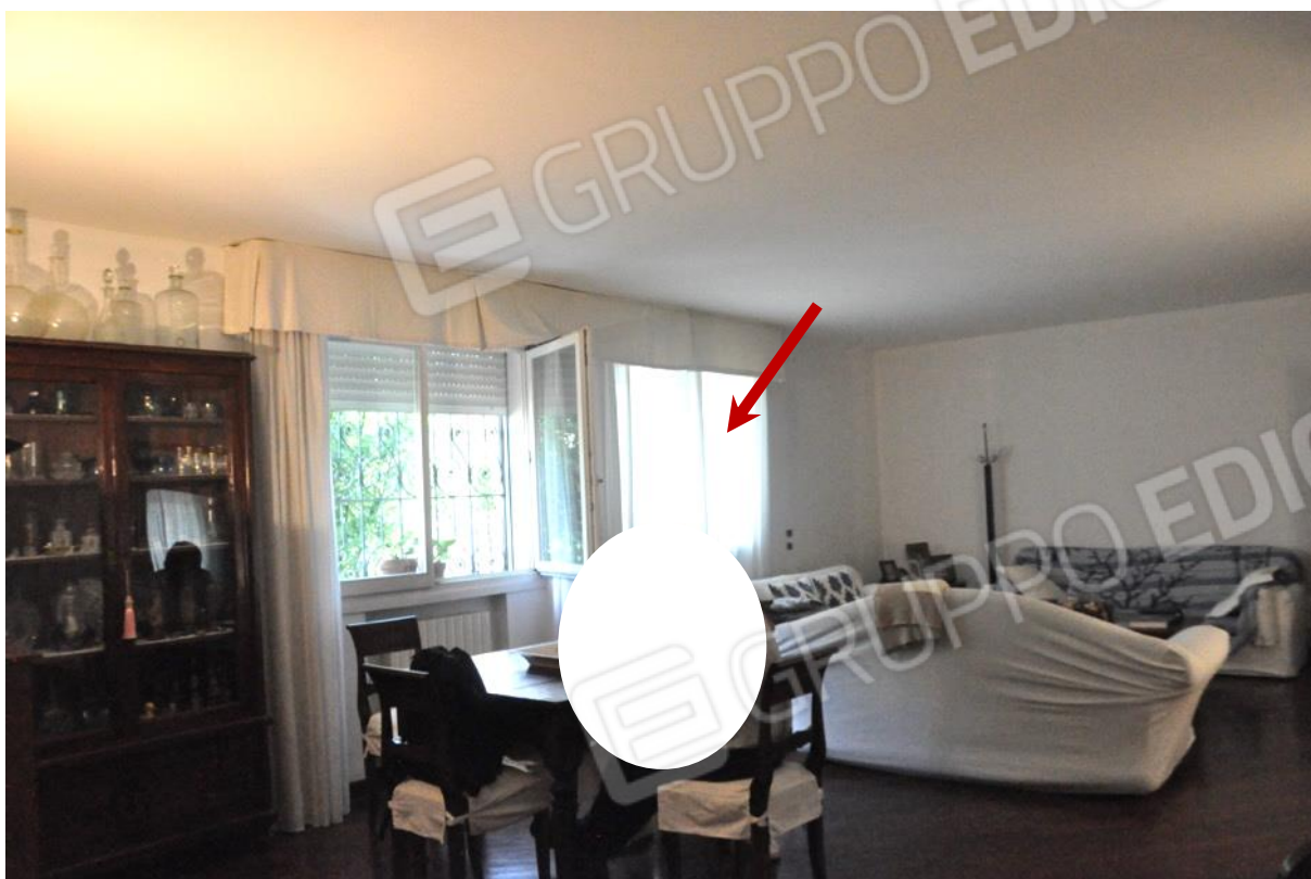
5. La finestra indicata dalla freccia in origine era l'ingresso dell'autorimessa, ora inglobata nel soggiorno.
