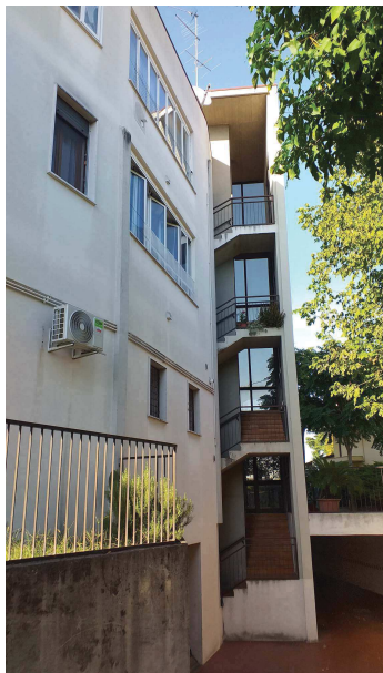
Retro lato sud
