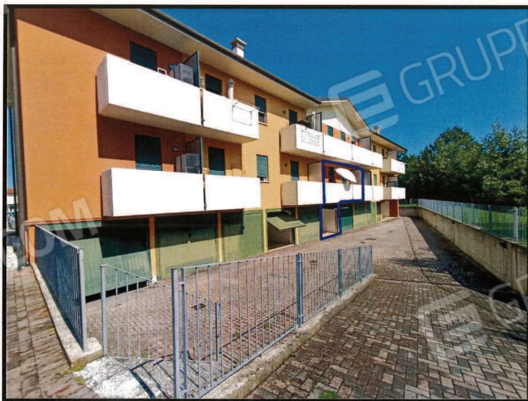
Foto n. 2: Vista appartamento al piano terra ed autorimessa al piano interrato, prospetto Est.
