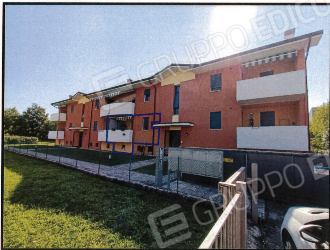
Foto n. 1: Vista appartamento al piano terra ed autorimessa al piano interrato, prospetto Ovest.
