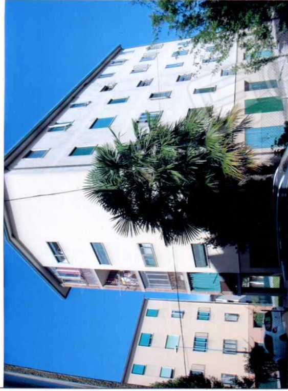
2 – Vista da Est fabbricato e scoperto condominiali
