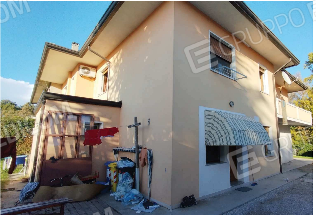
Veduta esterna dell'edificio
