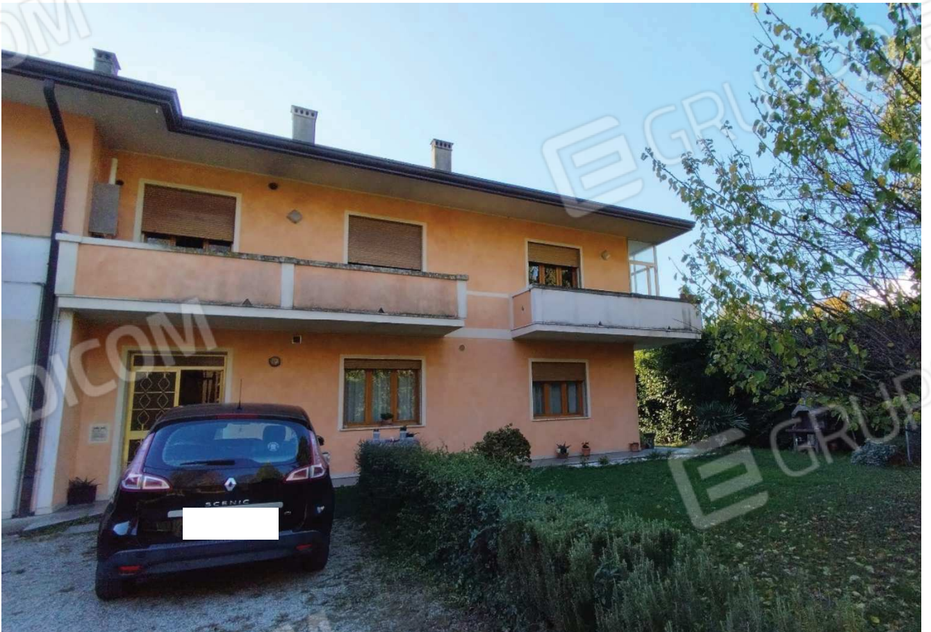
Veduta esterna dell'edificio
