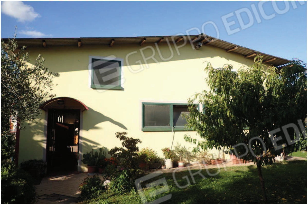
Foto 27 - esterno dell'edificio agricolo
