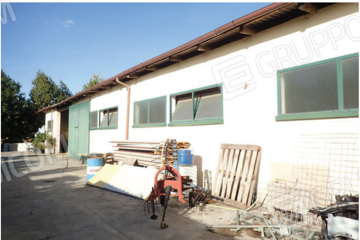
Foto 28 - esterno dell'edificio agricolo
