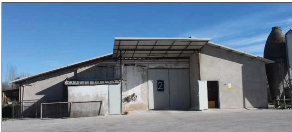
Figura 4 – esterno capannone (facciata Sud)
