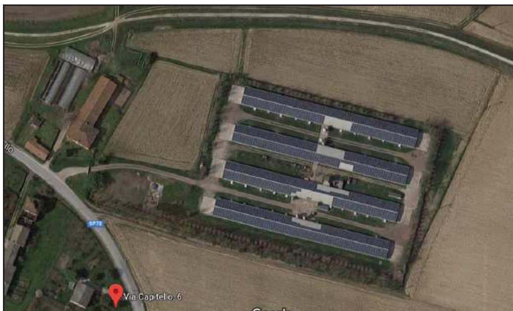
Figura 42 - foto satellitare del complesso
