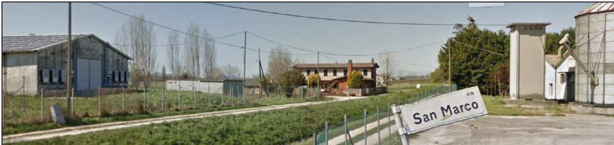
Figura 15 – Cabina ENEL comune oltre lo scolo (in Comune di Campagna Lupia)
