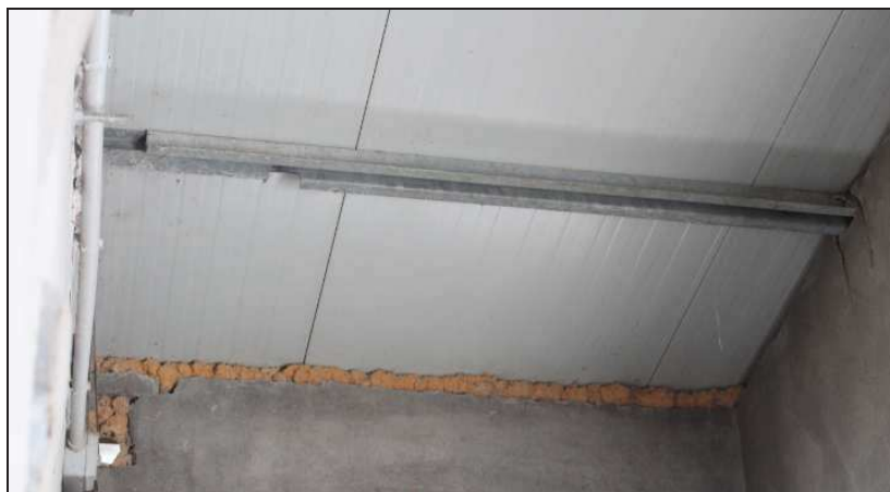
Figura 29 – particolare controsoffitto vestibolo capannone 2
