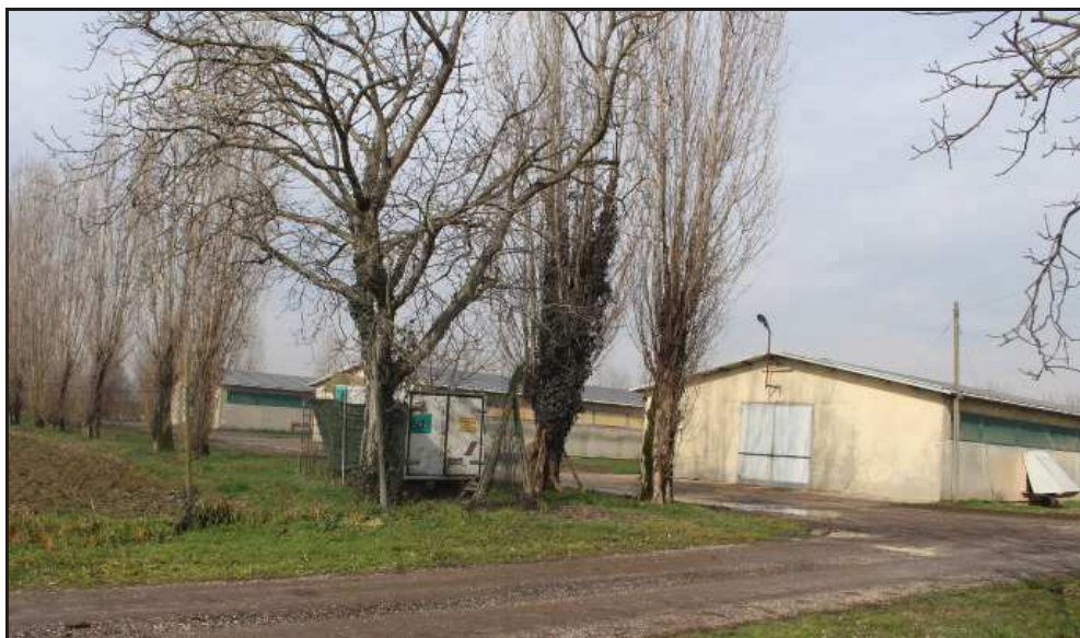
Figura 40 – il complesso visto dal vialetto di accesso
