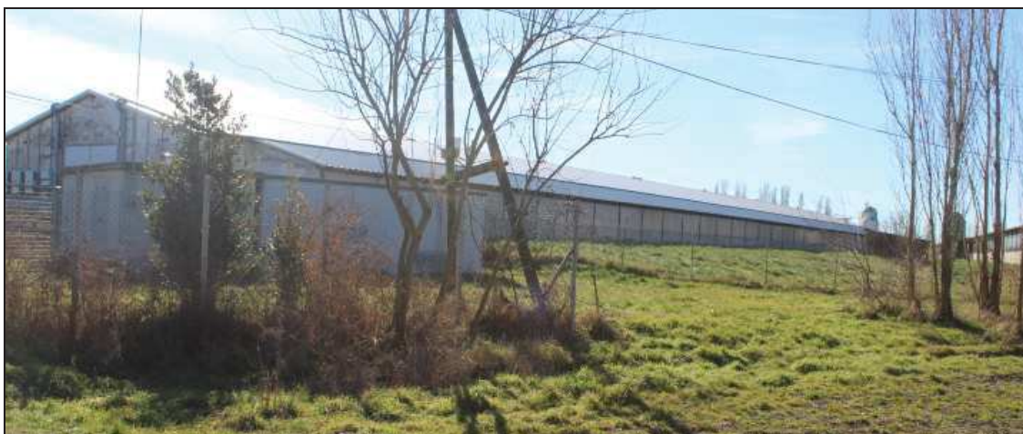
Figura 10 – Prospetti Nord e Ovest del terzo capannone (visto dai terreni)
