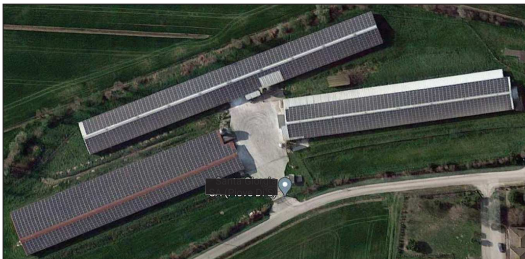
Figura 17 – stato attuale delle coperture
