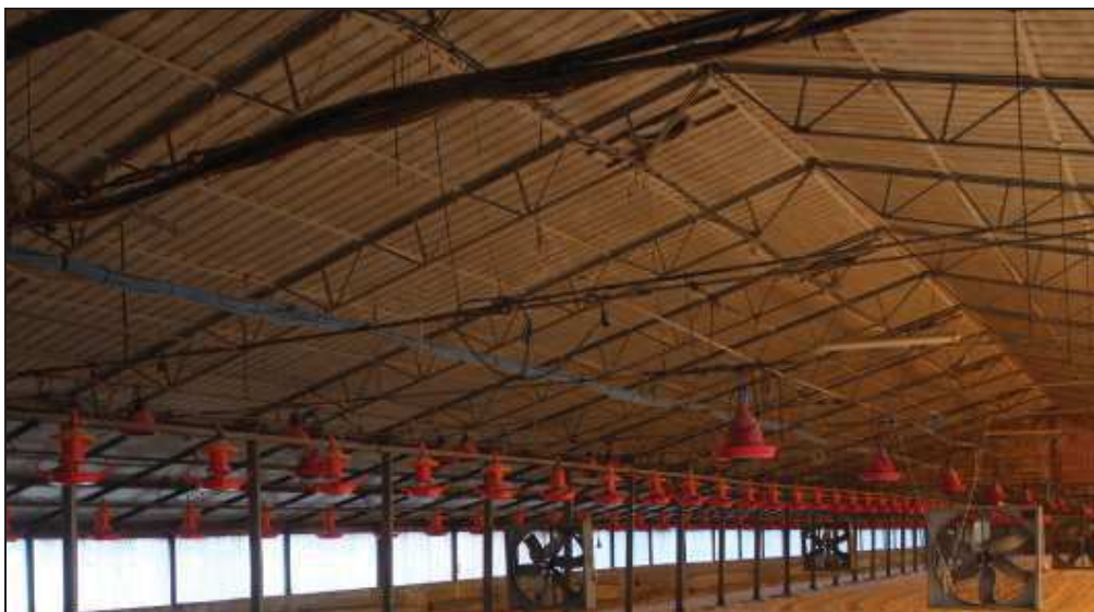
Figura 28 – controsoffitto del capannone 2 (uguale a quello del capannone 3)
