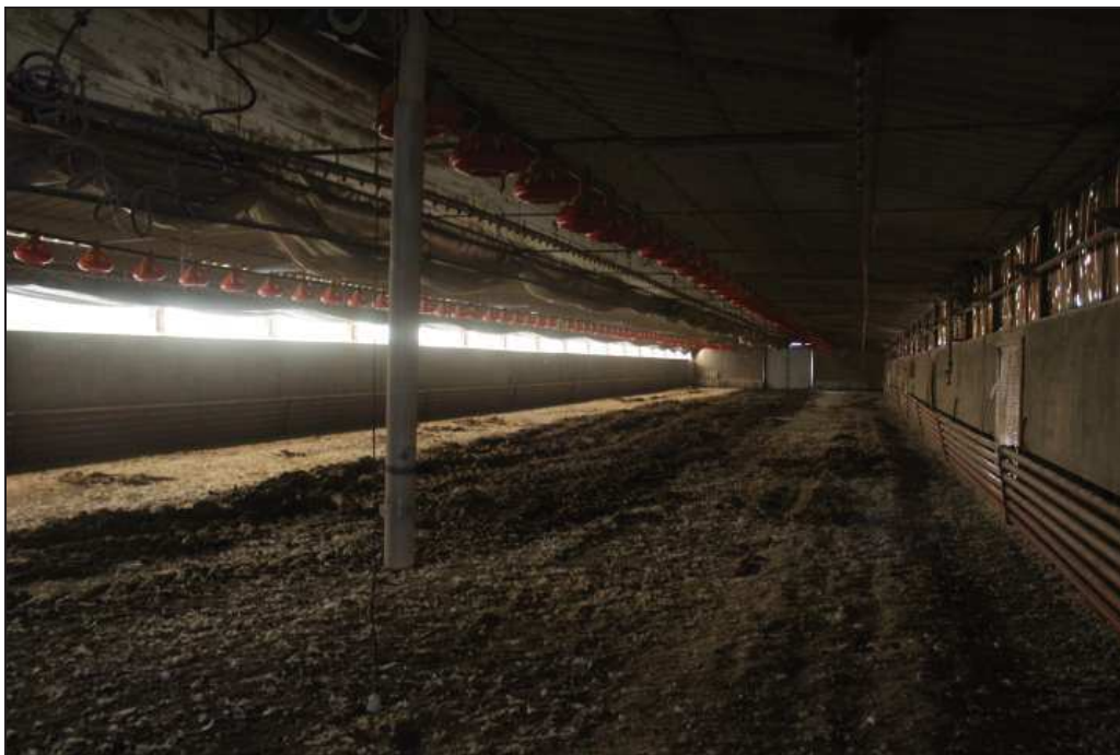
Figura 48 – Uno dei due reparti del capannone n. 3
