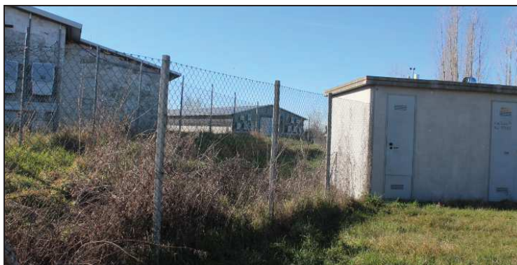
Figura 18 – Locali misure annessi all'impianto
