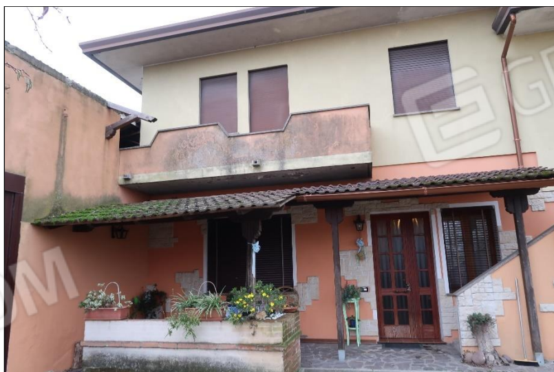
Foto n.5 - Ingresso piano terra - Lato Est
