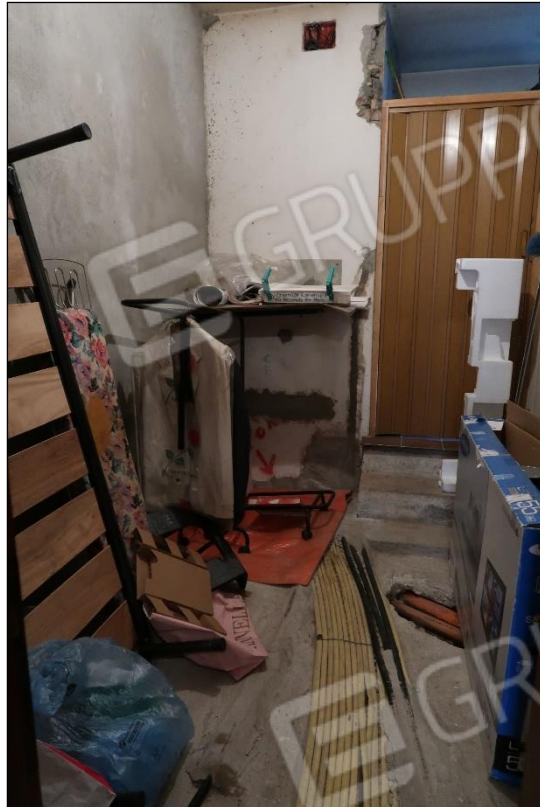
Foto n.22 - Bagno piano terra
