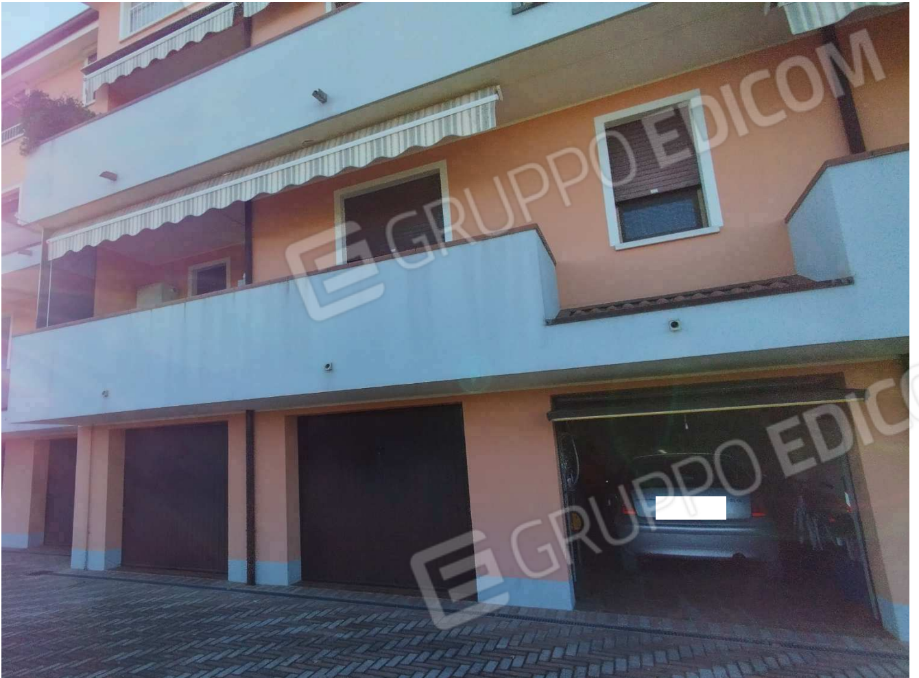
Scoperto carrabile verso il garage
