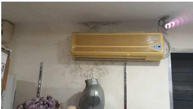
Split posto al piano interrato dell'area di vendita - segni di infiltrazione/perdite di acqua da impianto
