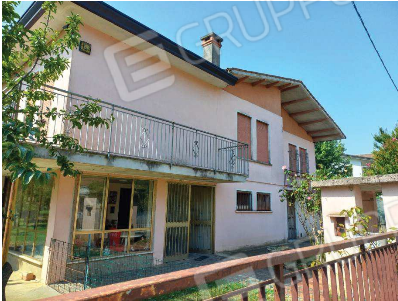
FOTO 1 / PROSPETTO SU VIA COLOMBARE
