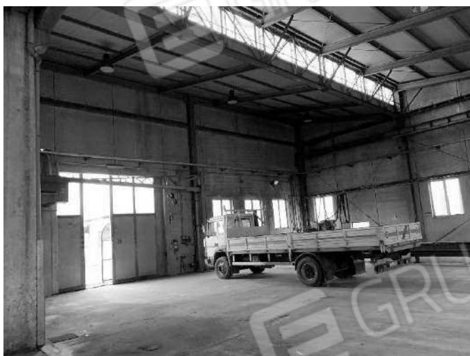
Foto 5 | Capannone (porzione non autorizzata)
