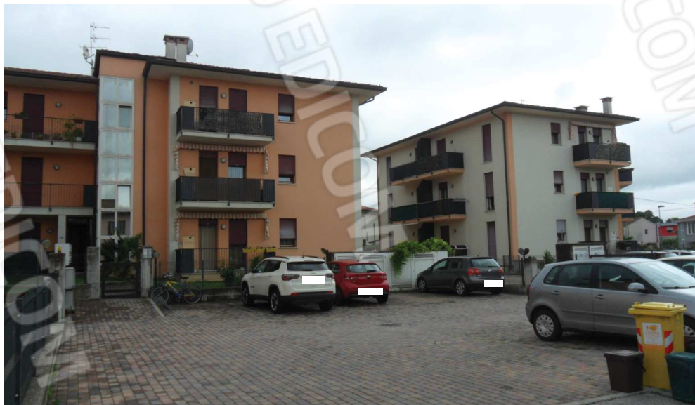
LOTTO 1 UNICO - FOTO 1 - PANORAMA COMPLESSO DEI DUE EDIFICI SUL LOTTO CON PARCHEGGIO ESTERNO AL COMUNE.
