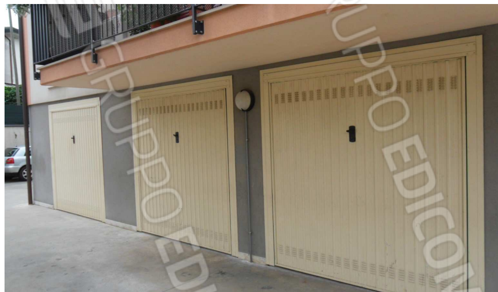
FOTO 4 - GARAGE APPRESO INTERRATO IN PRIMO PIANO
