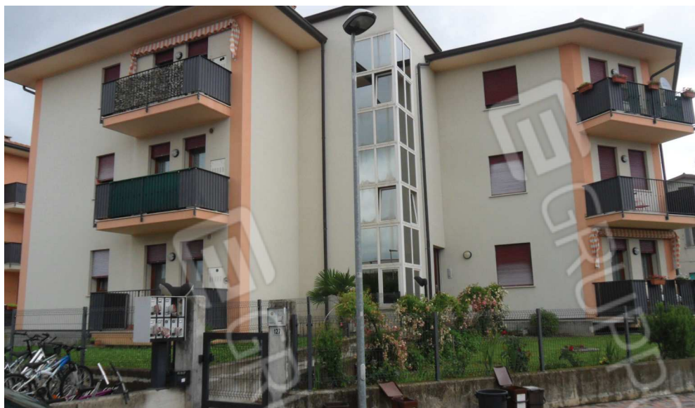
FOTO 3 - PARTICOLARE EDIFICIO CON UNITA' APPRESA AL PIANO PRIMO
