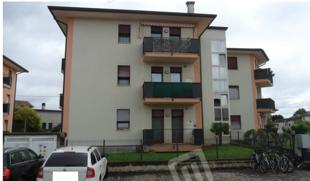
FOTO 2 - PARTICOLARE DELL'EDIFICIO A SUD CON L'UNITA' APPRESA
